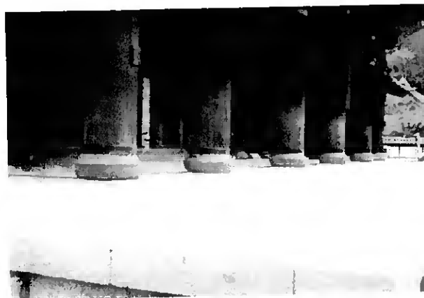
Figura 20: As colunas de madeira, deste templo japonês construído em 1628 A.D, têm umas sapatas que se podem mover, com alguma liberdade, na plataforma de rocha. Durante um sismo, a força lateral exercida nas sapatas é relativamente pequena – a terra treme mas a estrutura não (Lei da Inércia). In Bolt (1999)
