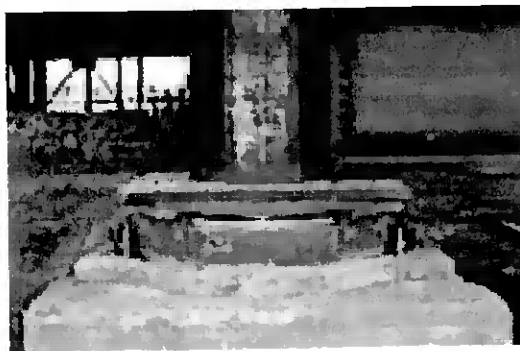
Figura 21: O pilar assenta numa base com alguma liberdade para se mover na horizontal pois, as superfícies envolvidas foram planificadas de modo a ter pouco atrito na zona central. No Aeroporto Internacional de São Francisco, construído para resistir a sismos de magnitude 8, utilizou-se este sistema de protecção anti-sísmica. Imagem retirada de: www.ideers.bris.ac.uk
