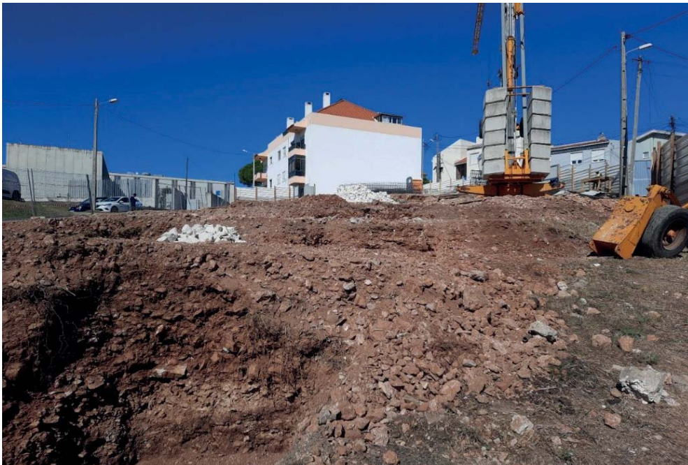
Fig. 1 – Rossio de Porto Salvo. Vista geral da área de construção com as valas abertas para as sapatas das estruturas a construir. Em primeiro plano, à esquerda, vala com a profundidade atingida de 1,90m, sendo visíveis as camadas de aterro identificadas.
