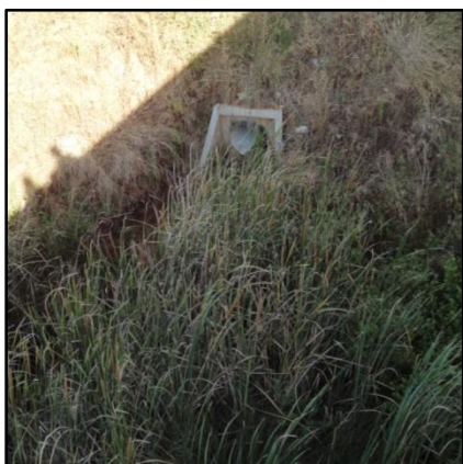
Fig. 61 – Despejos de águas para a ribeira de Alcantarilha, no “Amendoeiras golf resort”.
