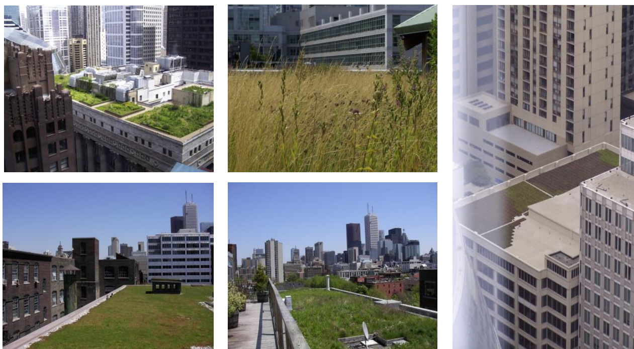
Figura 2.16 – Telhados verdes Chicago e Toronto, EUA Loder (2014)
