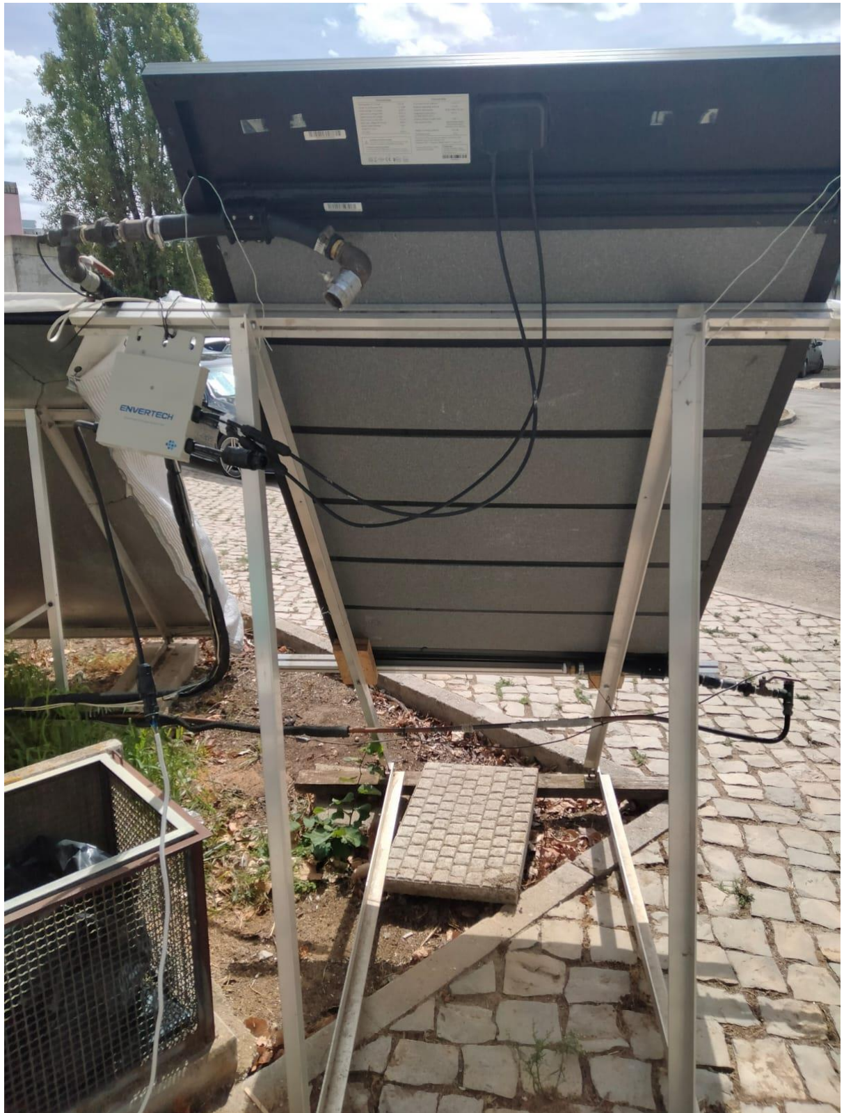
Figura 3.6-Conexões hidráulicas e elétricas do painel
