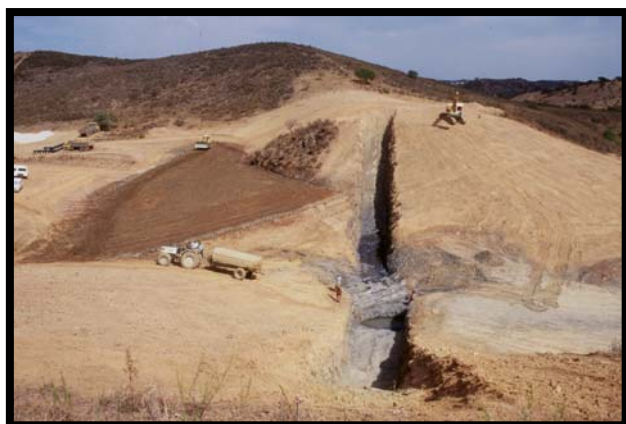
Fotografia 1 – Vista geral da fundação da barragem
