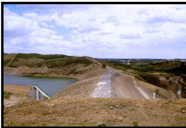
Fotografia 2 – Vista geral da barragem concluída
