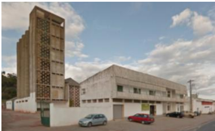
Figura 80 – Silos da Cooperativa de Santa Catarina da Fonte do Bispo
