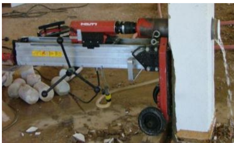
Figura 39 – Caroteadora em utilização
