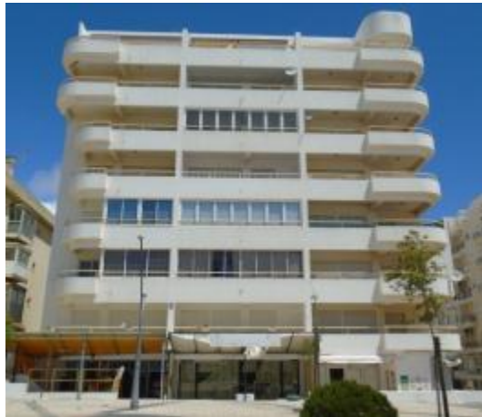
Figura 71 – Alçado principal do edifício
