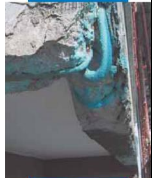
Ferros de armadura da frente duma varanda tratados com o Mapefer 1K
