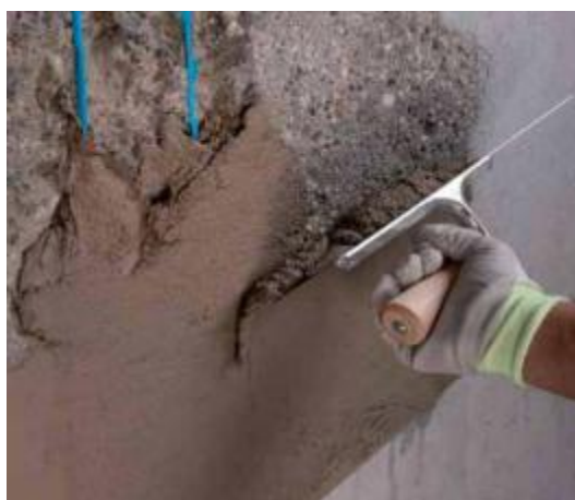
Figura 43 – Aplicação de argamassa para restauração do betão após proteção das armaduras [72]
