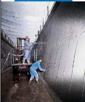
Canal hidroeléctrico Bertini - Robbiate (CO): acabamento com espátula
