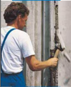
Demolição do betão degradado
