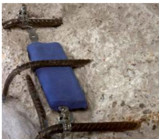
Figura 47 – Pormenor da aplicação de um ânodo de sacrifício numa estrutura existente [79]
