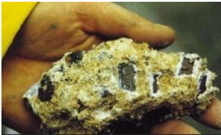
Figura 20 – Betão sujeito ao ataque por sulfatos com formação de taumasite [49]
