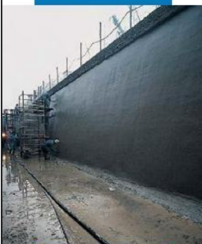
Canal hidroeléctrico Bertini - Robbiate (CO): vista do conjunto
