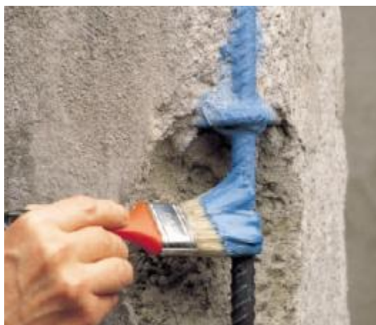
Figura 42 – Aplicação de revestimento protetor anticorrosivo em armaduras [72]
