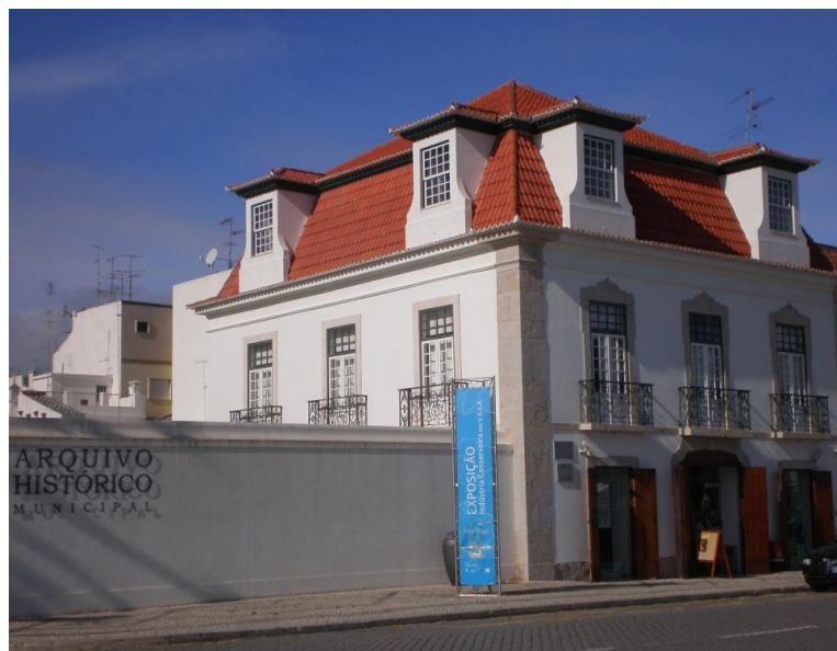
Fig. 4: Fachada do Arquivo Histórico Municipal de VRSA.
