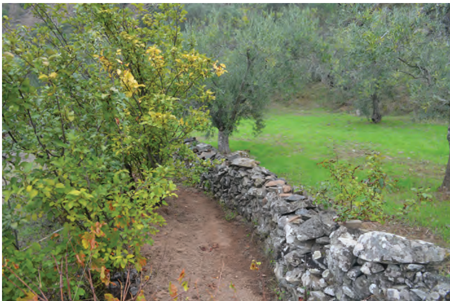
Figura 9 - A sanja: estrutura de drenagem construída por um muro de pedra e solta e um valado
