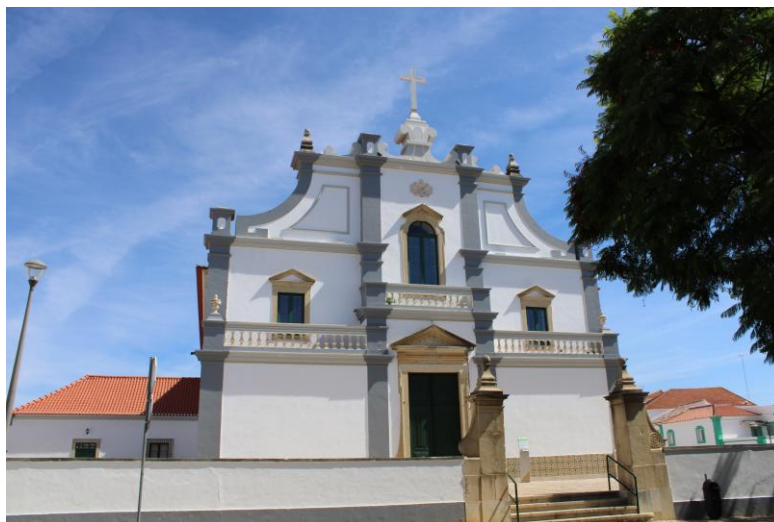
Figura 12- Fachada da igreja de Nossa Senhora da Luz, Lagoa. Fonte: Arquivo pessoal, 24 set. 2022.
