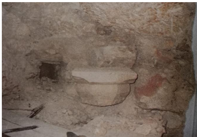
Figura 52- Base e aduelas encontradas em março de 1993 durante as obras de restauro da sacristia.
