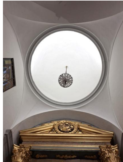
Figura 30- Aspeto interior da calote esférica vista do interior da Capela do Santíssimo, igreja de Nossa Senhora da Luz, Lagoa. Fonte: Arquivo pessoal, 8 de set. 2024
