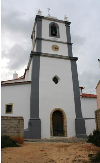
Figura 21- Torre sineira da igreja de Nossa Senhora da Luz, Lagoa. Fonte: Arquivo pessoal, 11 fev. 2023.
