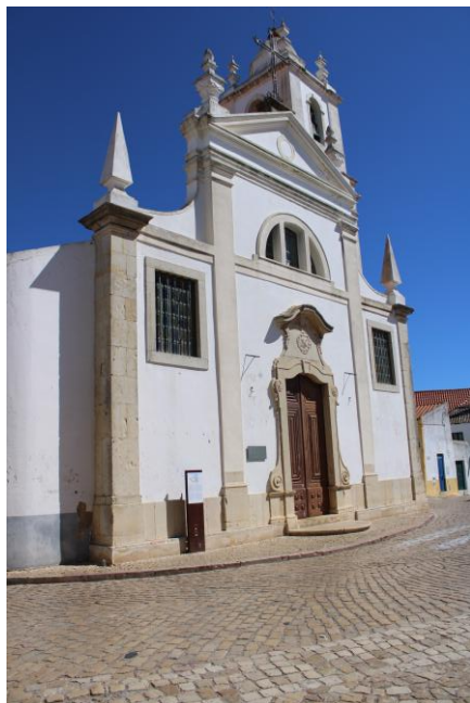
Figura 13 – Fachada da igreja de Nossa Senhora da Conceição, Alcantarilha, Silves. Fonte: Arquivo pessoal, 24 set. 2023.
