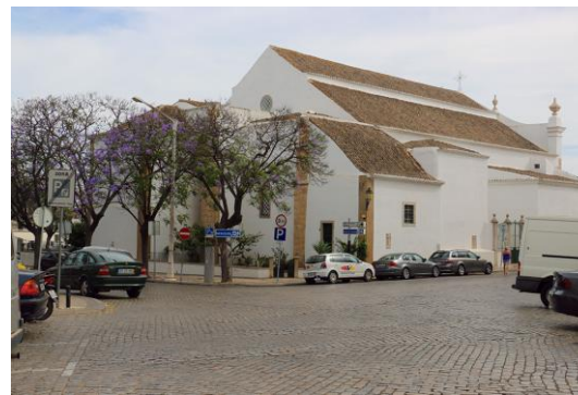
Figura 26- Exterior da igreja Paroquial de São Pedro de Faro. Fonte: http://www.sulinformacao.pt , 23 nov. 2022.
