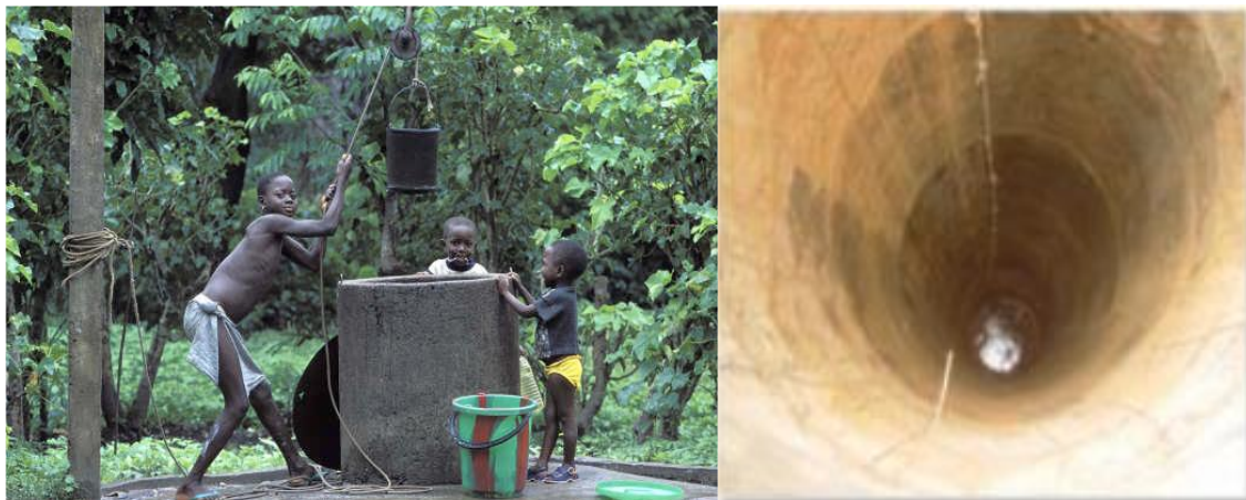
Figura 17: A parte externa e interna de um poço melhorado
