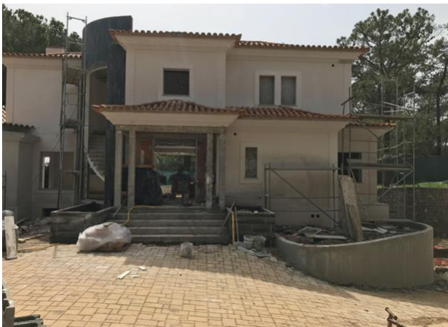
Fig.36 - Fotografia antes da intervenção. Fonte: Autora, 2017
