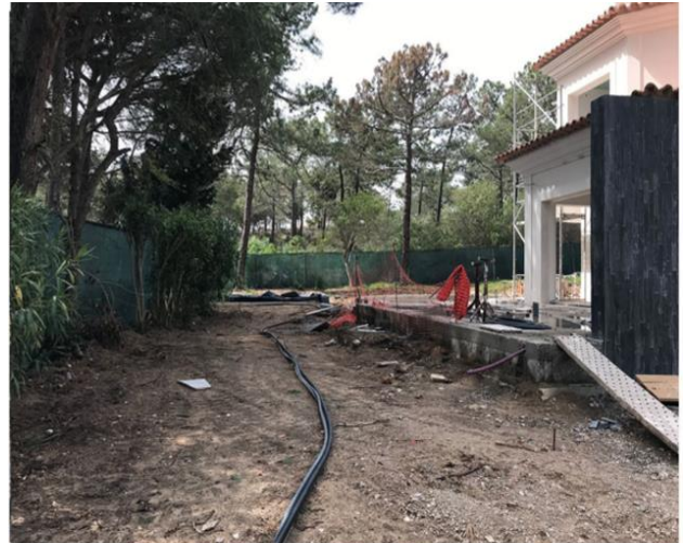
Fig.35 -Fotografia do que existia antes da intervenção
