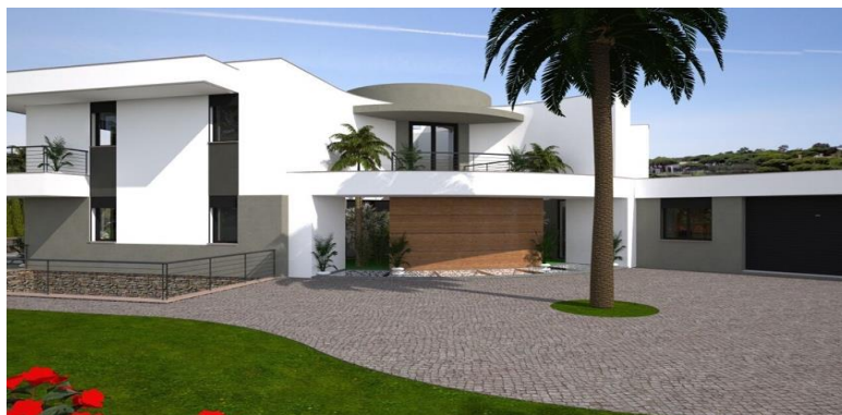
Fig. 4- Área de estacionamento e acesso à garagem- Fonte: Arq. João Cabrita.
