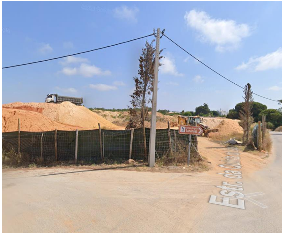
Fig.20- Fotografia do lado Norte do Lote, onde existem bastantes trabalhos com maquinaria pesada de cargas e descargas. Fonte: Google Earth.2014
