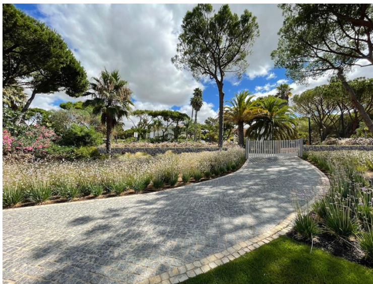
Fig.38 - Entrada do lote após a conclusão da obra. Fonte: Autora, 2017
