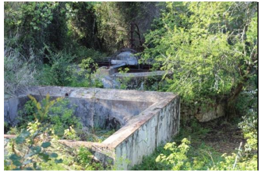
37 – Antigos Tanques de água
