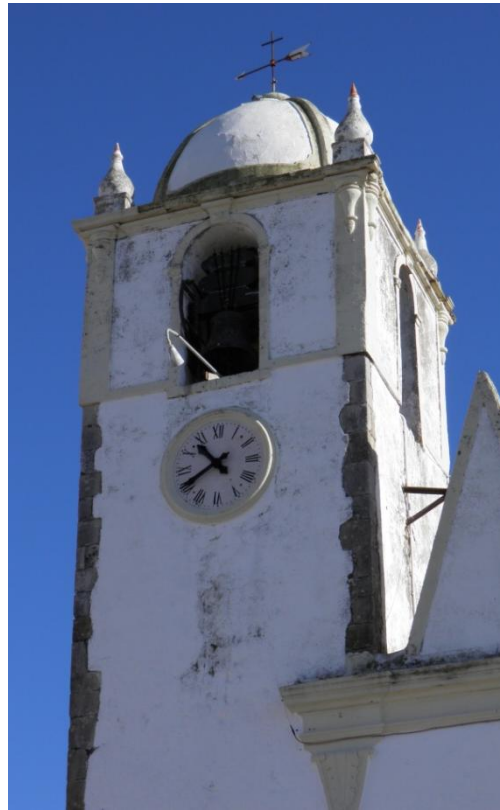
Fig. 87. Aspecto geral do remate da torre sineira da igreja da Luz (fachada Oeste). (foto do autor)
