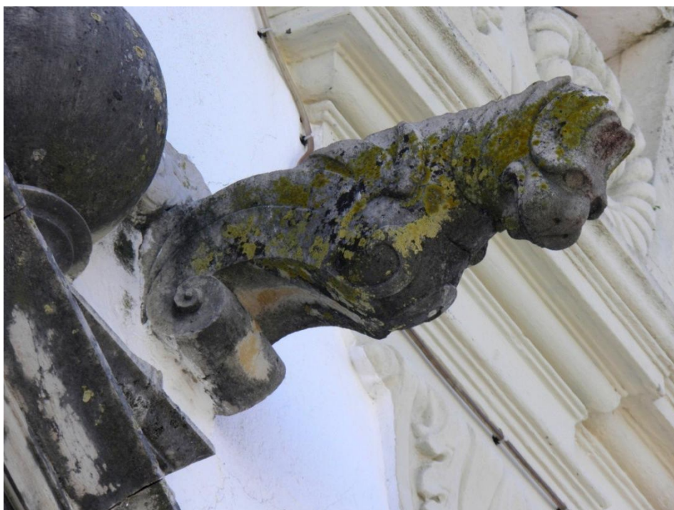
Fig. 31. Gárgula integrada no portal axial da igreja da Luz (lado da Epístola). (foto do autor)
