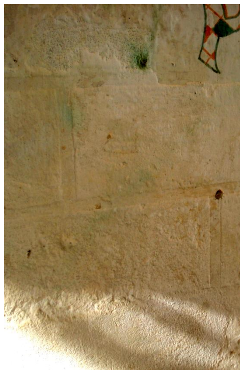
Fig. 79. Vestígios de revestimento parietal a simular cantaria aparelhada, na parede de uma das antigas capelas laterais do extinto convento de São Francisco de Tavira. (foto do autor)
