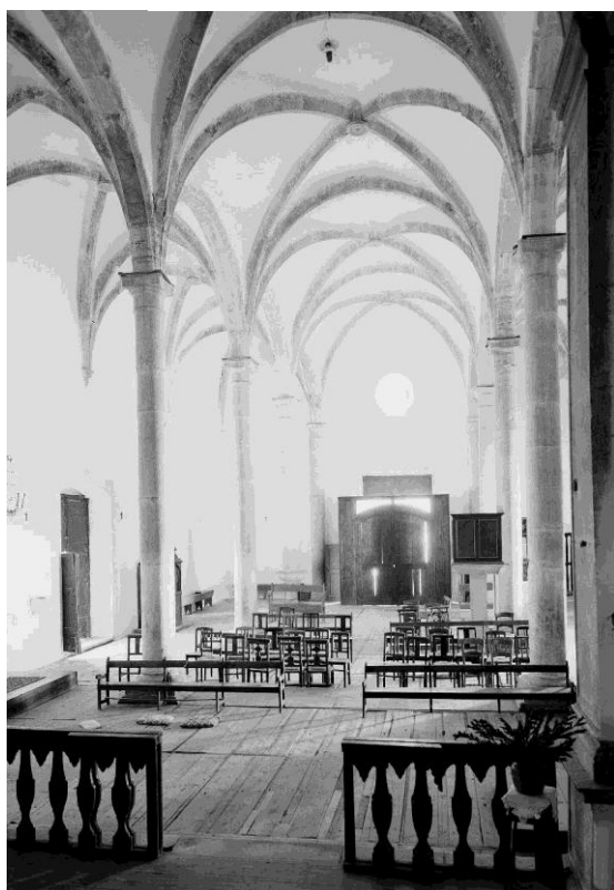
Fig. 25. Aspecto geral do interior da igreja-salão da Luz de Tavira, na década de 60 do século XX.
