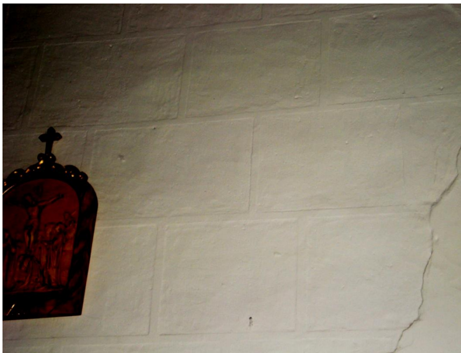
Fig. 77. Vestígios de revestimento parietal a simular cantaria aparelhada, na parede Norte da nave da igreja da Luz de Tavira. (foto do autor)
