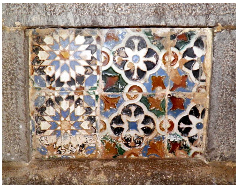
Fig. 143. Painel de azulejos hispano-árabes nos degraus de acesso ao retábulo da capela-mor (Evangelho). (foto do autor)
