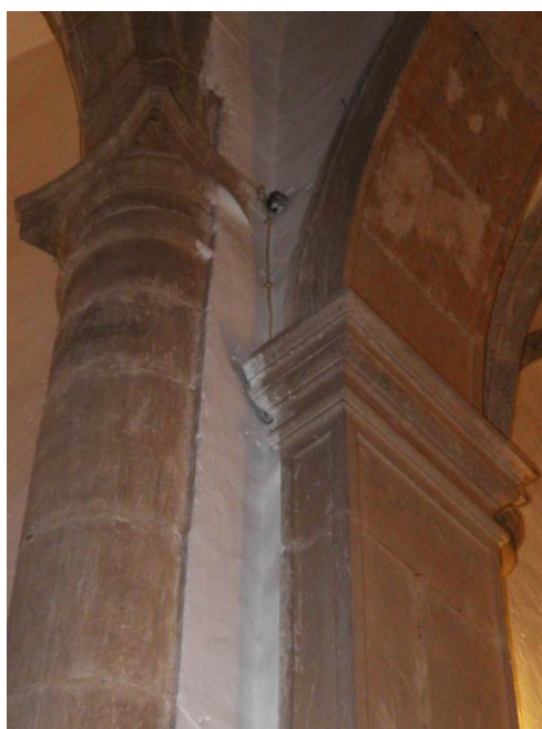
Fig. 66. Pormenor da articulação entre o arco da capela-mor e o primeiro par de colunas da nave (Evangelho). (foto do autor)
