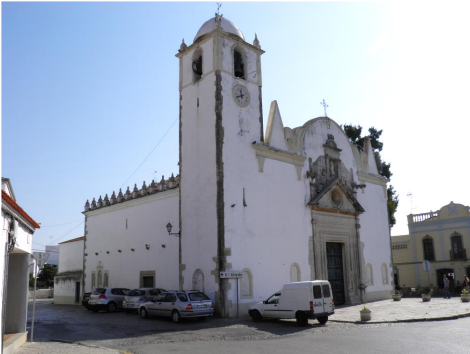
Fig. 33. Aspecto geral do exterior da igreja da Luz de Tavira (frontispício e fachada lateral Norte). (foto do autor)
