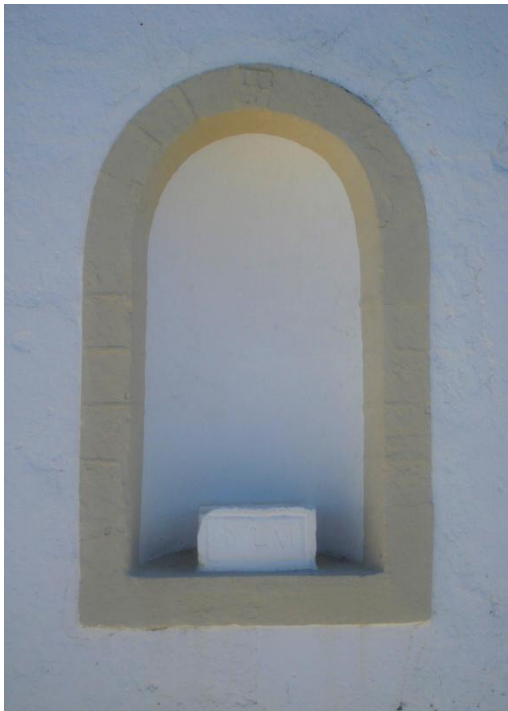
Fig. 50. Nicho de Estação da Via-Sacra na parede Oeste da igreja da Luz de Tavira, ainda com o respectivo pedestal (foto do autor)
