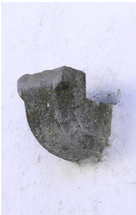
Fig. 54. Um dos cachorros de pedra existentes na parede lateral Norte. (foto do autor)
