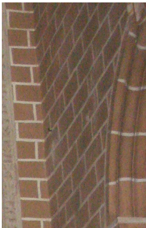
Fig. 78. Revestimento parietal a simular cantaria aparelhada, na Sé de Évora. (foto do autor)
