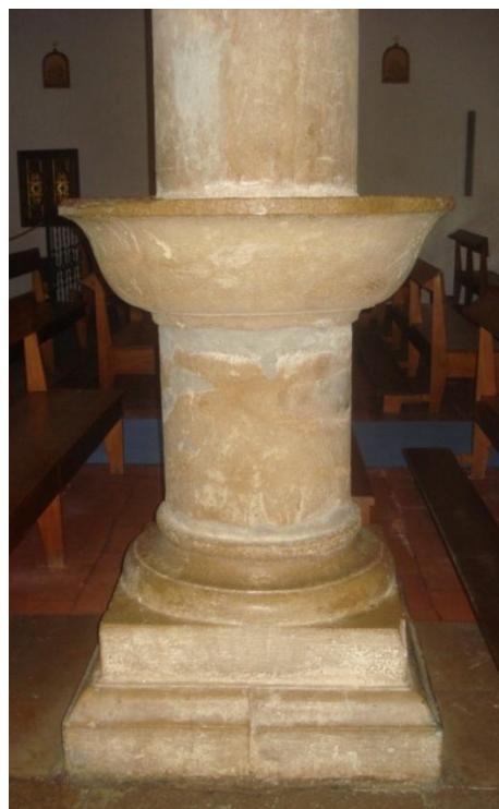
Fig. 83. Pia de água benta, renascentista, integrada numa das colunas da nave. (foto do autor)
