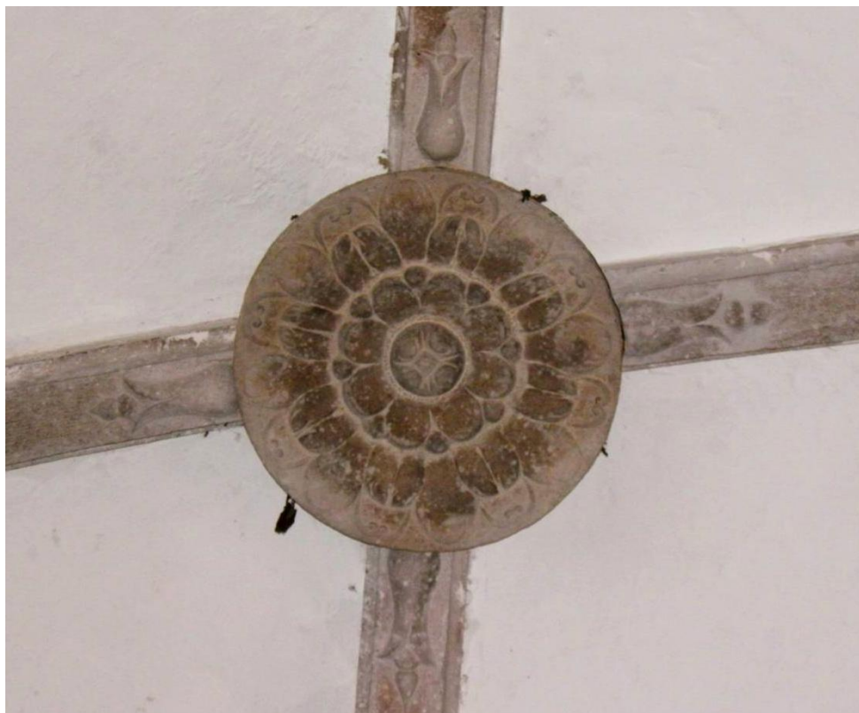
Fig. 57. Pedra de fecho da abóbada da capela-mor da igreja da Luz de Tavira. (foto do autor)
