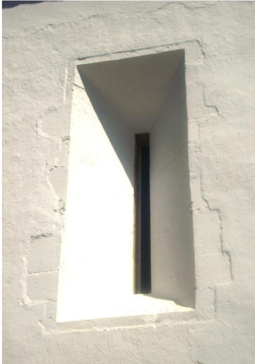
Fig. 75. Fresta de iluminação, em cantaria, na parede lateral Sul. (foto do autor)
