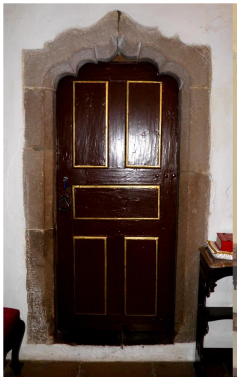
Fig. 61. Porta com moldura pentalobulada na parede lateral da capela-mor (Epístola). (foto do autor)
