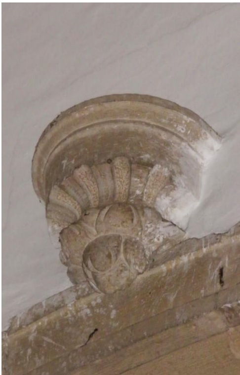
Fig. 29. Mísula no remate do arco triunfal da capela-mor da igreja da Luz. (foto do autor)
