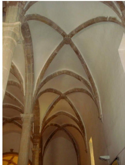
Fig. 70. Aspecto geral das abóbadas da nave lateral (Sul) da igreja da Luz. (foto do autor)
