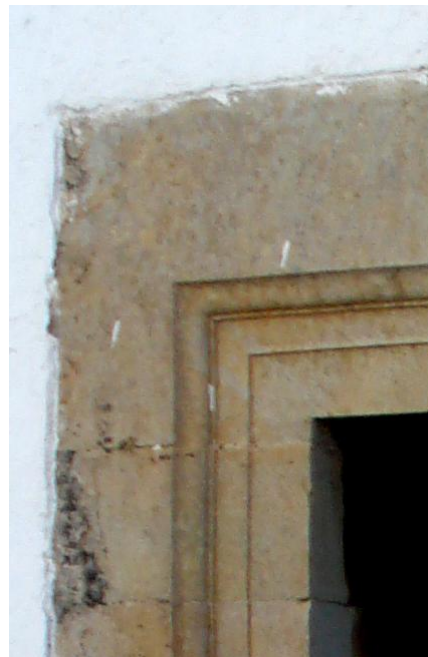
Fig. 98. Pormenor do portal lateral renascentista, na fachada Norte da igreja da Luz de Tavira. (foto do autor)
