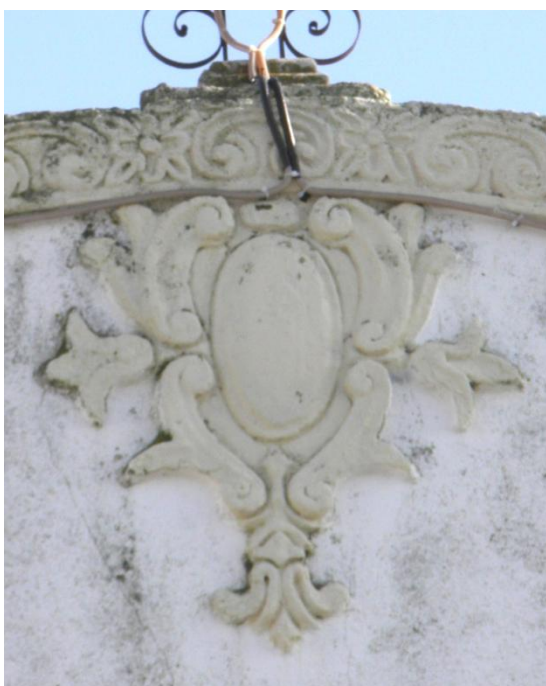
Fig. 41. Trabalhos de massa no frontispício da igreja da Luz de Tavira. (foto do autor)
