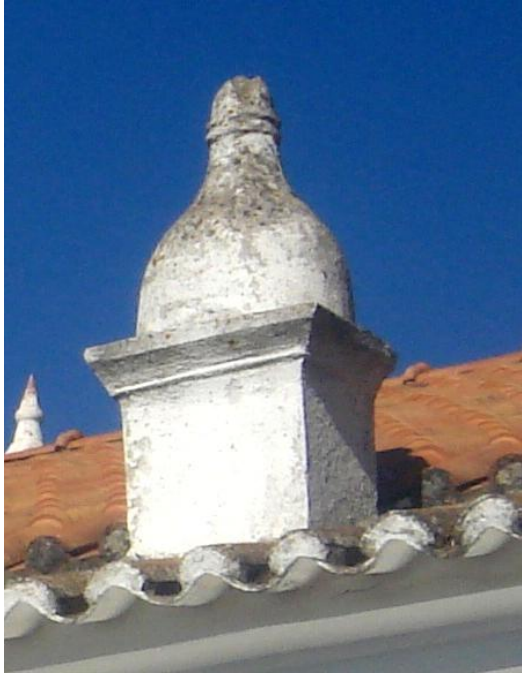
Fig. 45. Elemento arquitectónico decorativo (“torrinha”) no topo da parede lateral (Sul) da igreja da Luz de Tavira (foto do autor)
