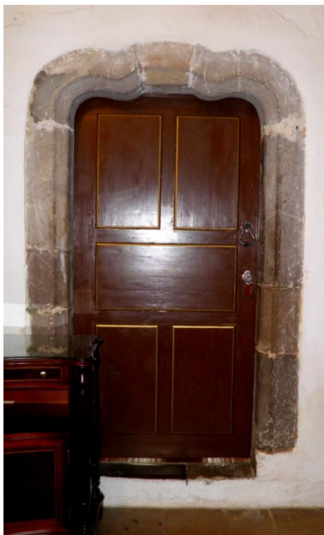
Fig. 60. Porta com moldura trilobulada na parede lateral da capela-mor (Evangelho). (foto do autor)
