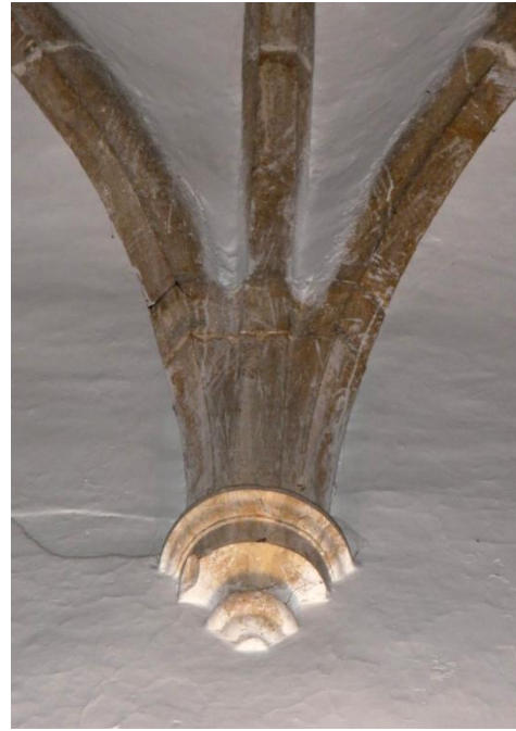
Fig. 72. Misula numa das paredes laterais da nave (Norte). (foto do autor)
