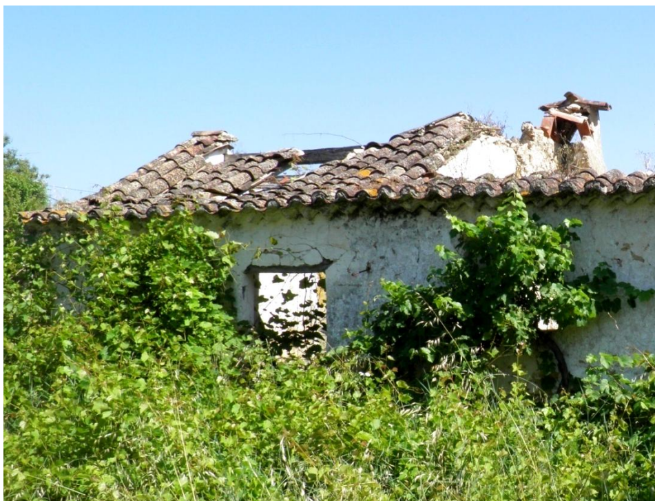
Fig. 9. Casa térrea com duplo beirado, no sítio da Igreja. (foto do autor)
