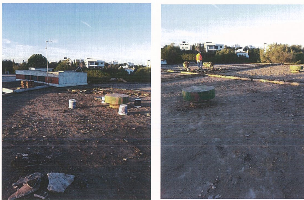
Figura 2.56 – Remoção de todo o material impermeabilizante
