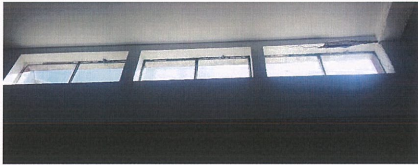
Figura 2.54 – Janelas envidraçadas em mau estado de conservação
