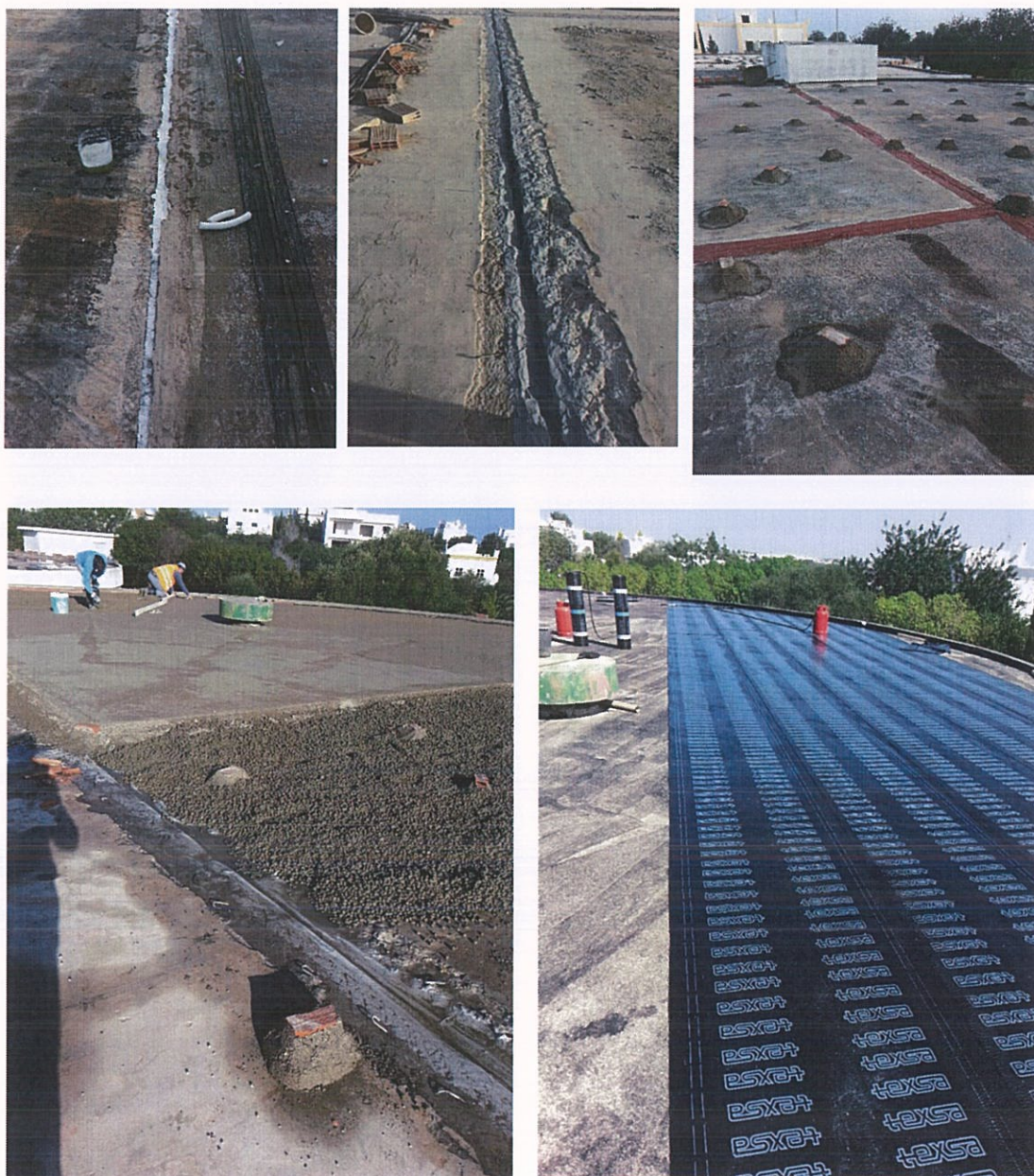
Figura 2.57 – Reparação das juntas de dilatação, camada de forma e impermeabilização
