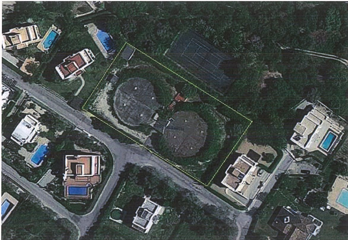
Figura 2.52 – Vista aérea do reservatório de Perogil, na urbanização com o mesmo nome
