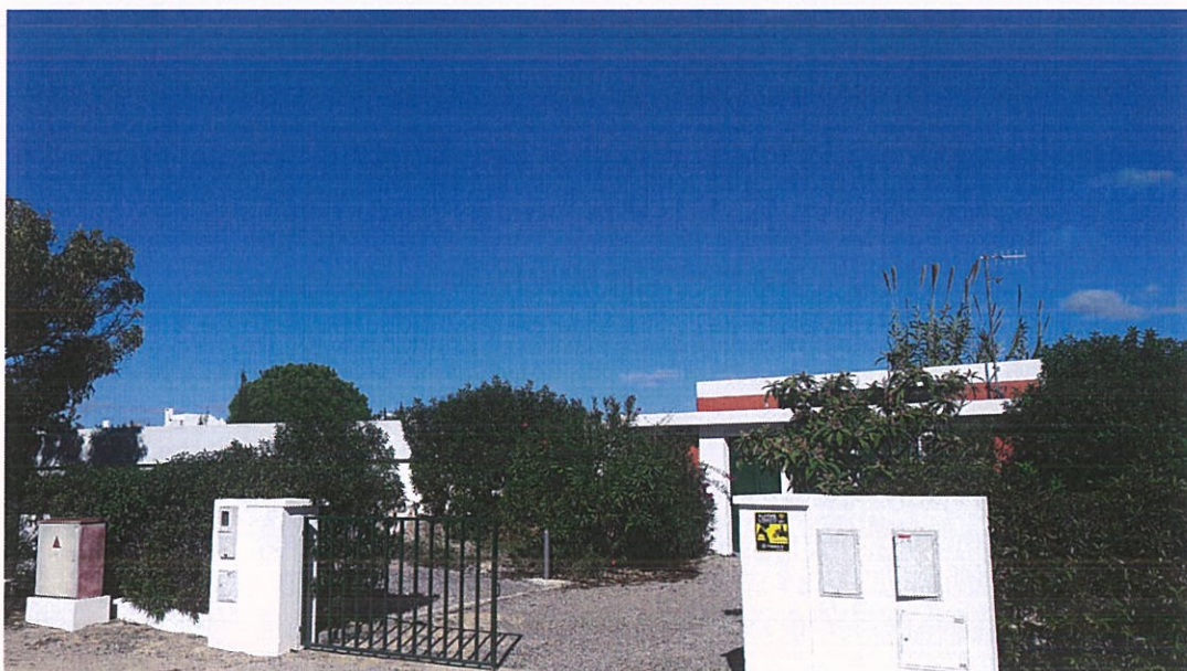
Figura 2.53 – Vista da entrada principal do reservatório de Perogil
