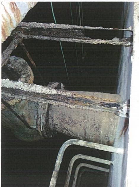
Figura 2.58 – Eliminação da tubagem e material obsoleto do interior da célula esquerda
