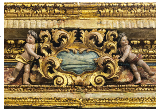
Faro. Igreja de São Francisco. Pormenor da cornija. Foto Marco Pedro.
