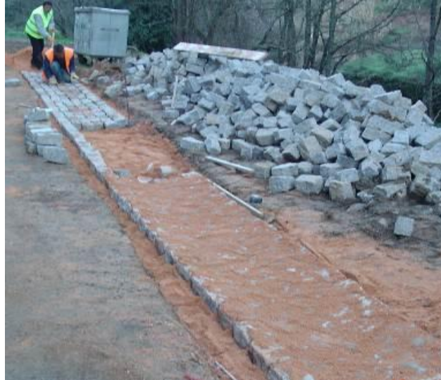
Figura 2.05 – Exemplo de caleira em meia-cana de sienito Fonte: Miguel Francisco (CMM)
