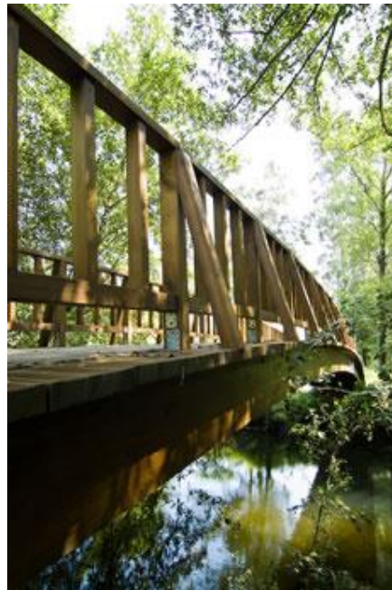
Figura 5.36 – Ponte realizada pela empresa Carmo,S.A. em Espanha
