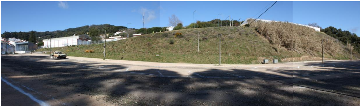
Figura 2.02 – Panorâmica do talude do heliporto
