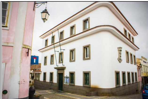
Figura 1.01 – Edifício dos Paços do Concelho, Monchique
