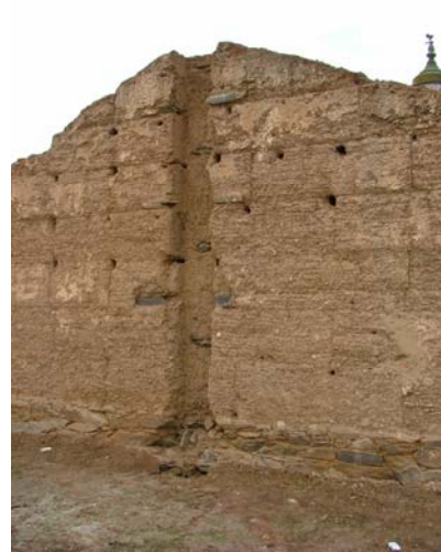
Imagen 4 - Vista del refuerzo
