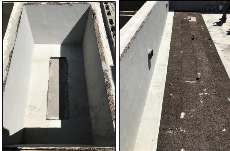
Figura 38 Argamassa de camada base com rede de fibra de vidro no interior do tanque secundário (direita) e do tanque principal (esquerda)
