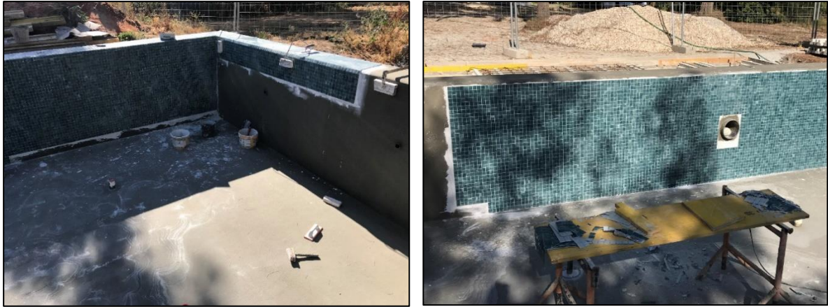
Figura 43 Aplicação da argamassa de colagem no revestimento cerâmico no interior do tanque (a)
