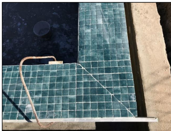
Figura 45 Detalhe da esquina na aplicação da argamassa de colagem no revestimento cerâmico no interior do tanque
