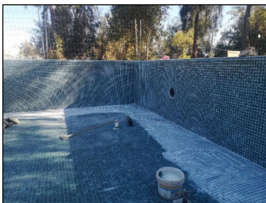
Figura 47 Rejuntamento do revestimento cerâmico no interior do tanque(b)
