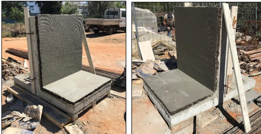
Figura 51 Parede experimental – camada de impermeabilização com rede de fibra de vidro
