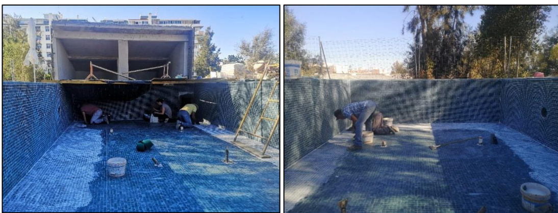
Figura 46 Rejuntamento do revestimento cerâmico no interior do tanque (a)
