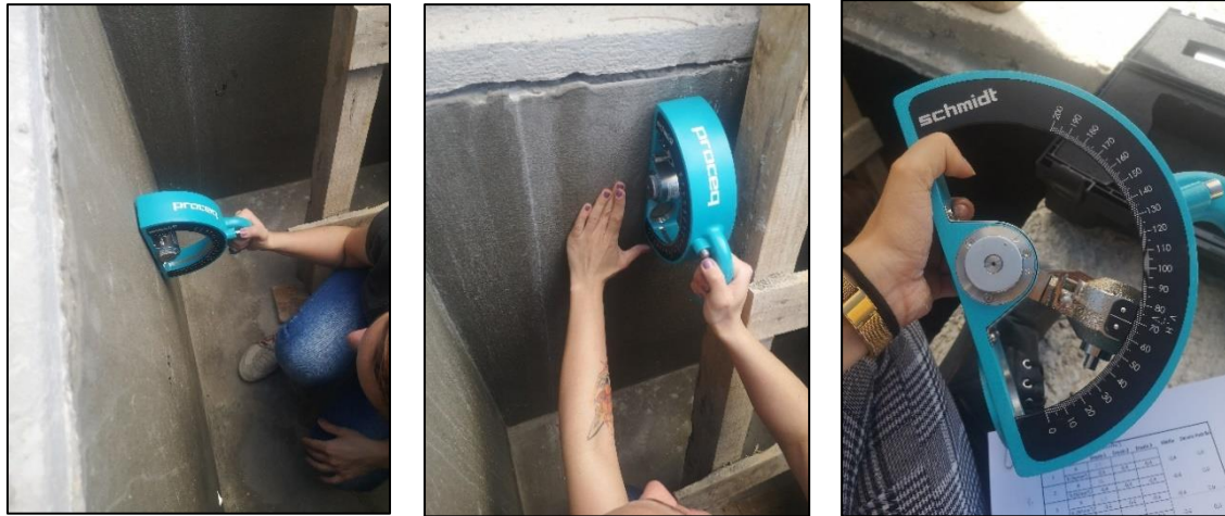
Figura 85 Ensaio Pêndulo de Schmidt – Tanque secundário
