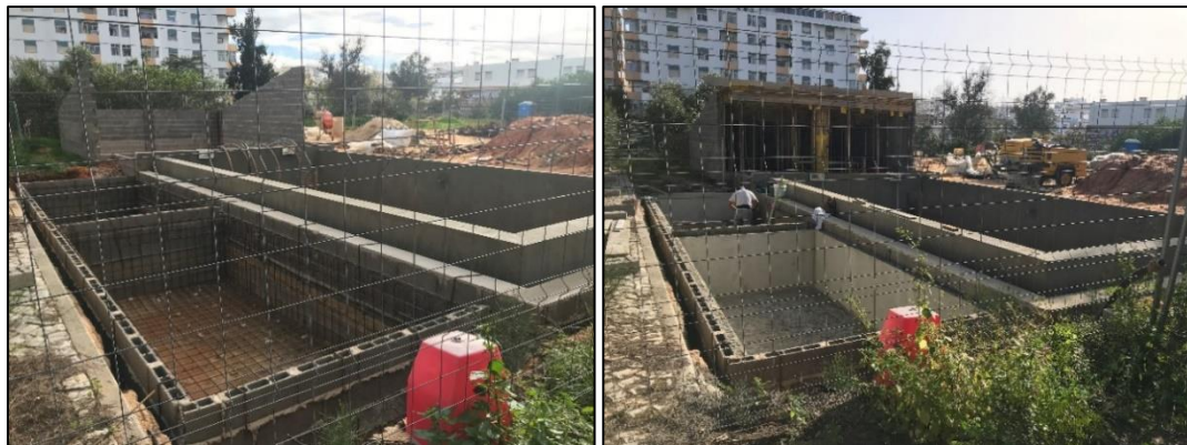
Figura 27 Montagem armadura nos tanques secundários
