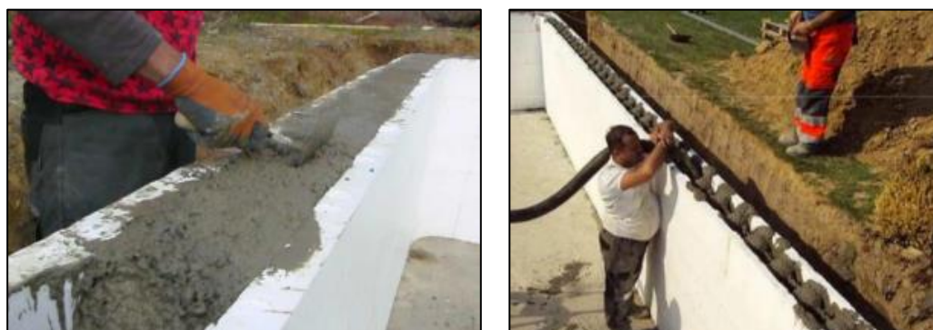
Figura 7 Betonagem em blocos de EPS (Sistems, 2021)
