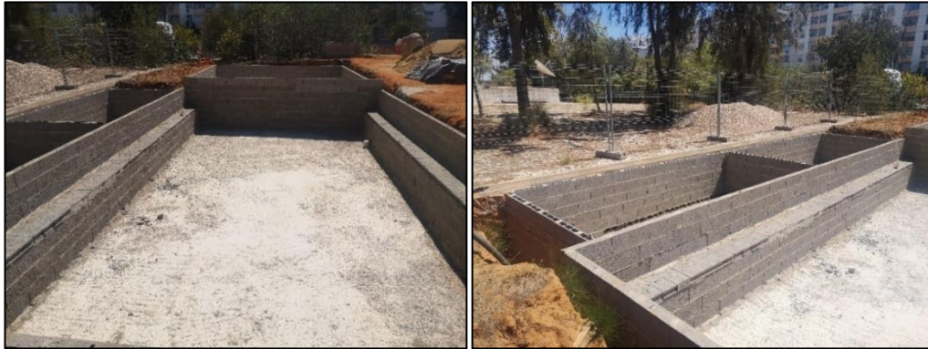
Figura 22 Cofragem perdida – Tanque principal e tanques secundários
