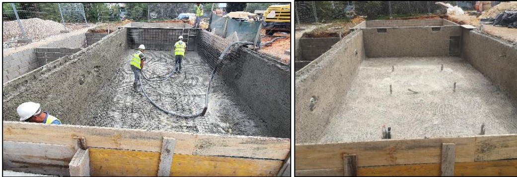
Figura 25 Betonagem do tanque principal
