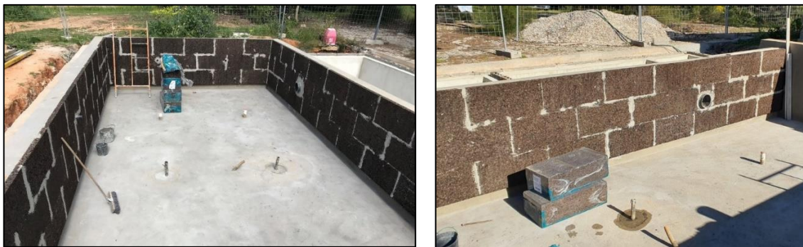
Figura 35 Aplicação do ICB no interior do tanque do protótipo
