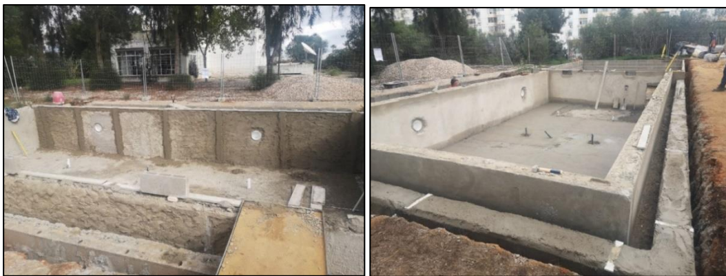
Figura 26 Regularização da superfície – aplicação de reboco
