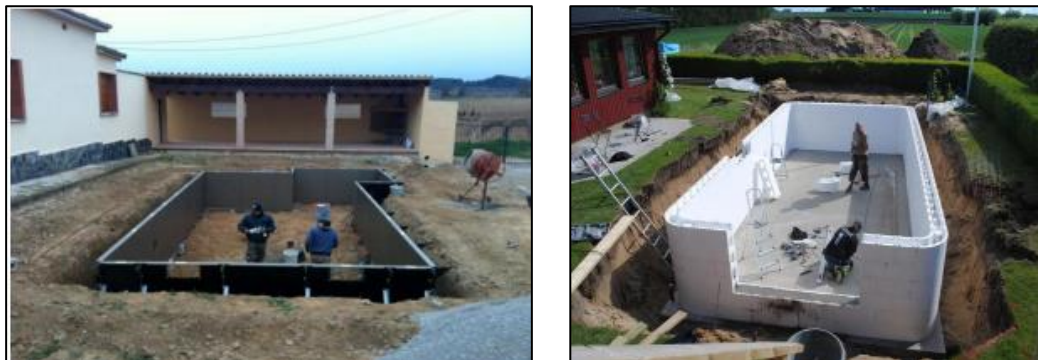
Figura 6 Montagem de cofragem perdida (Sistems, 2021)
