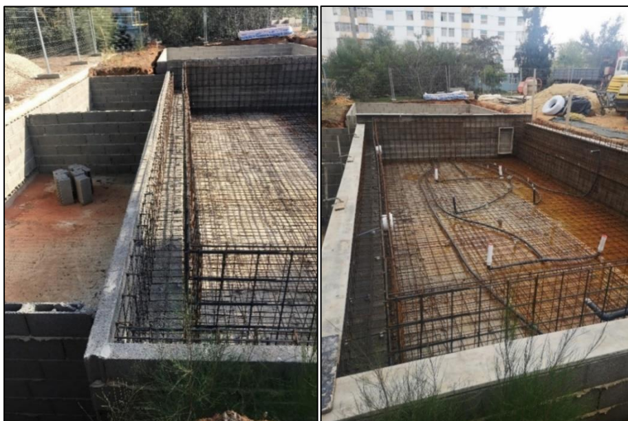
Figura 23 Cofragem perdida (direita) e montagem da armadura no tanque principal (esquerda)
