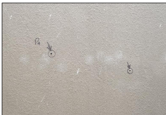
Figura 80 Ensaio de penetração controlada – Tanque secundário
