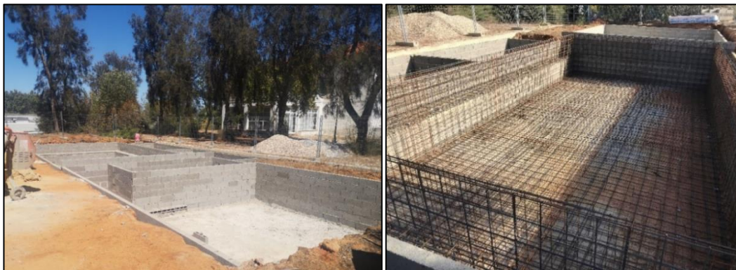
Figura 23 Cofragem perdida (direita) e montagem da armadura no tanque principal (esquerda)
