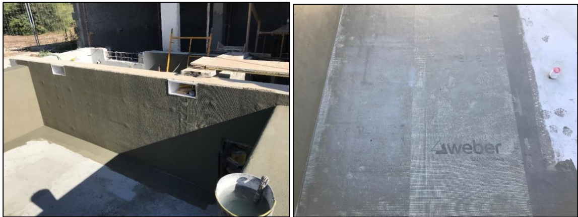
Figura 41 Aplicação da argamassa de impermeabilização com rede de fibra de vidro no interior do tanque (b)
