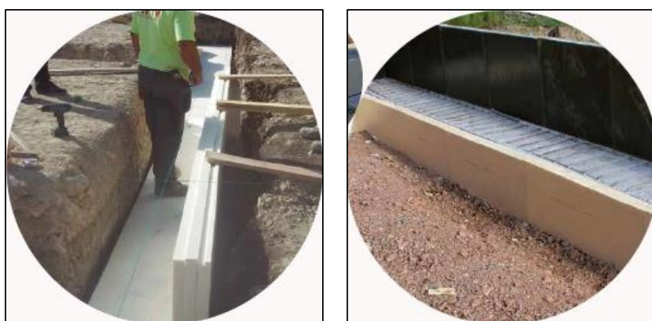
Figura 11 Isolamento com placas XPS no solo (Romão, 2015)
