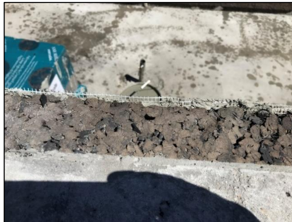
Figura 39 Pormenor da estrutura até a camada base
