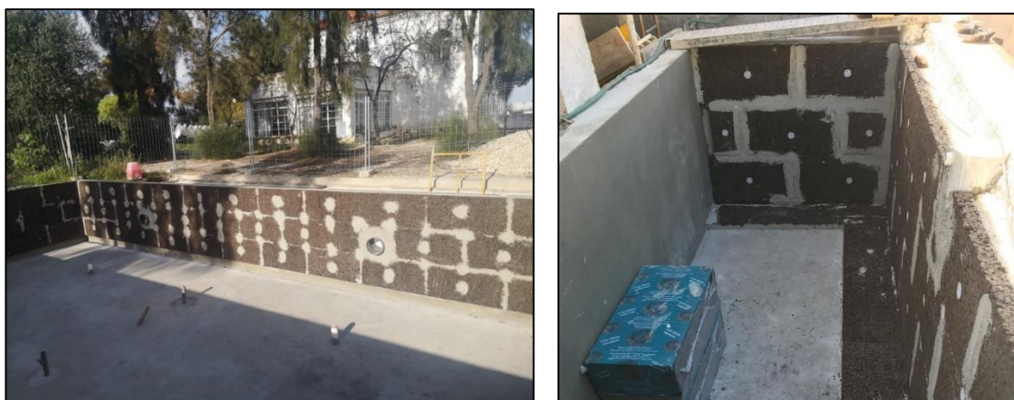
Figura 36 Aplicação de fixações no interior do tanque do protótipo (direita) tanque de compensação (esquerda)
