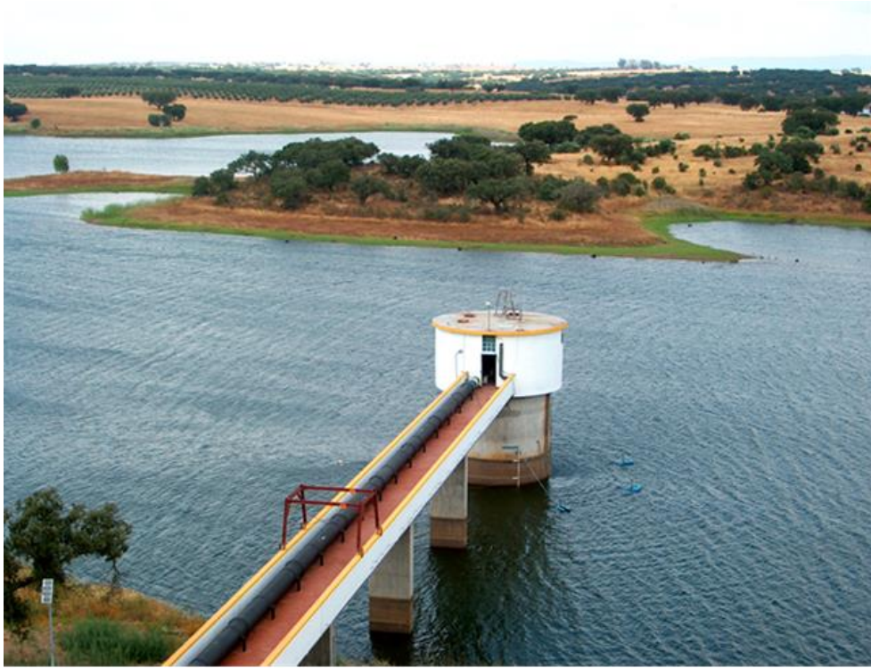
Figura 5 - Aspeto geral da captação do Monte Novo (Fonte: APA, Contrato Concessão emitido à AdVT, 2010)
