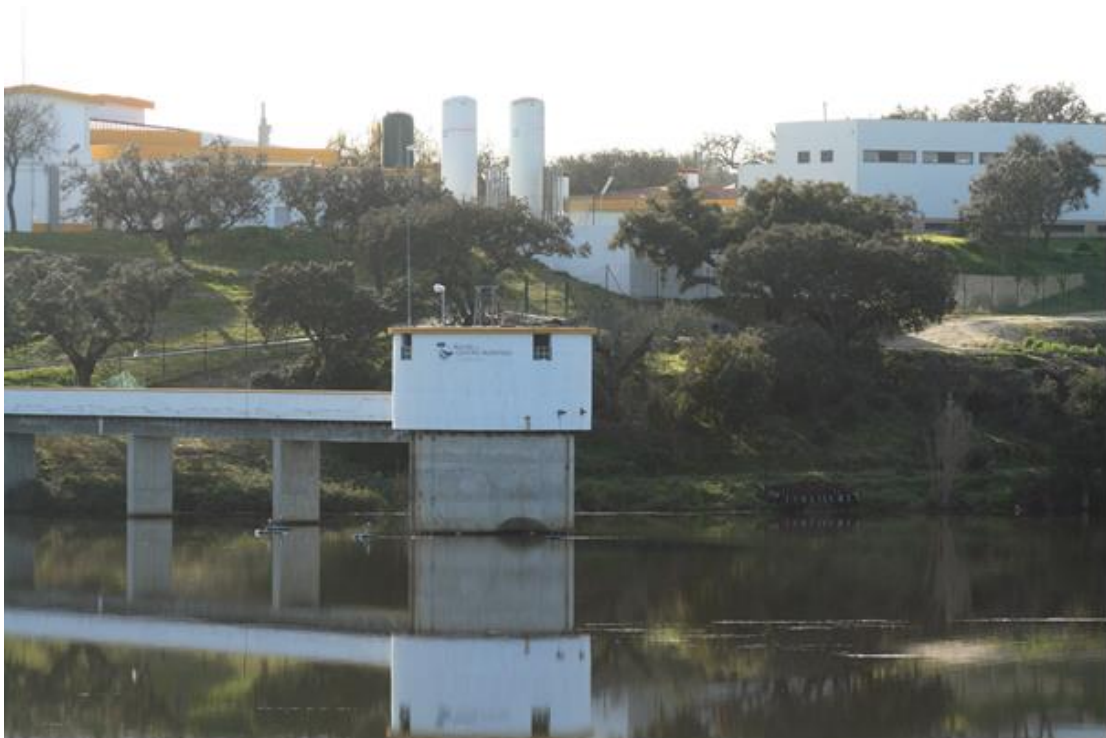
Figura 6 - Aspeto geral da captação e da ETA de Monte Novo (Fonte: APA, Contrato Concessão emitido à AdVT, 2010)
