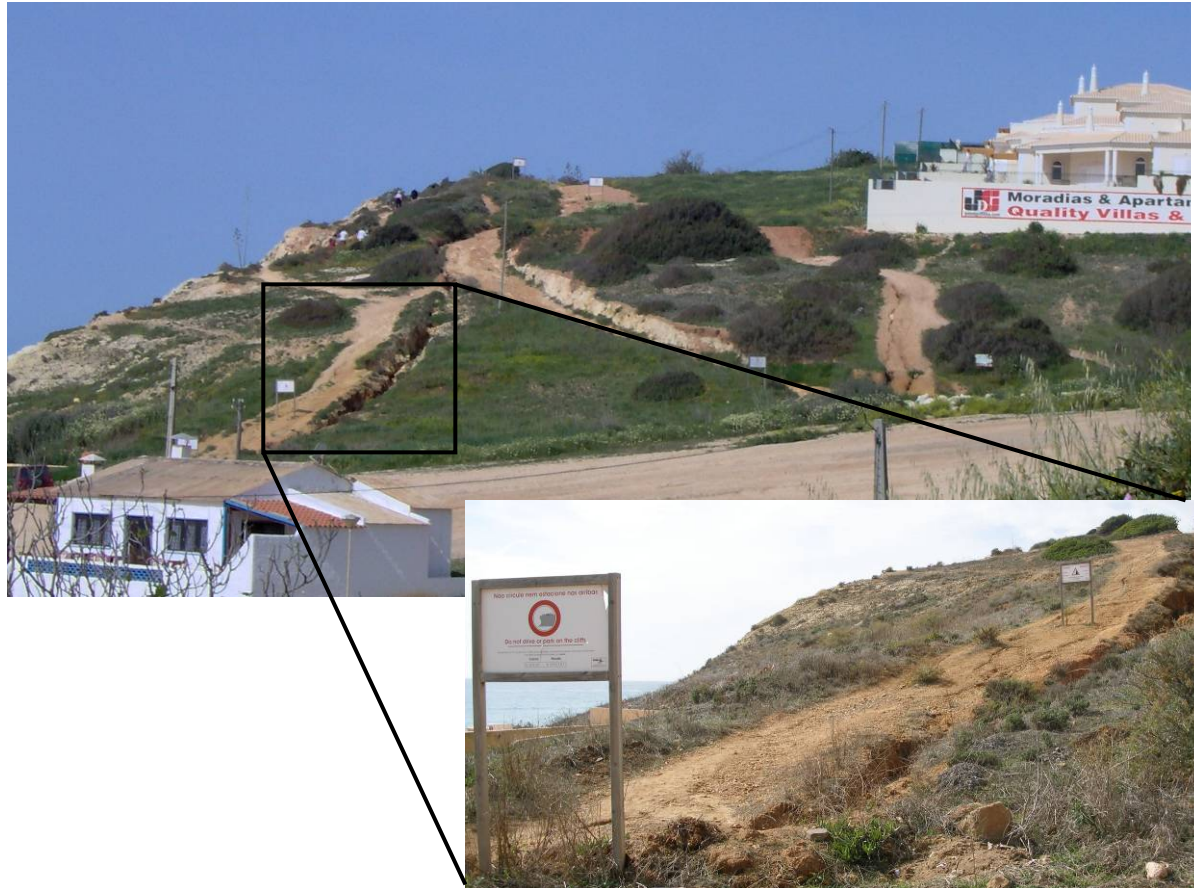
Figura 11: Aspecto do topo da arriba, com as zonas de fissuras bem visíveis. Note-se a existência de vários avisos
