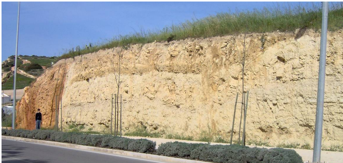
Figura 9: Aspecto da zona da falha em Abril de 2006.
