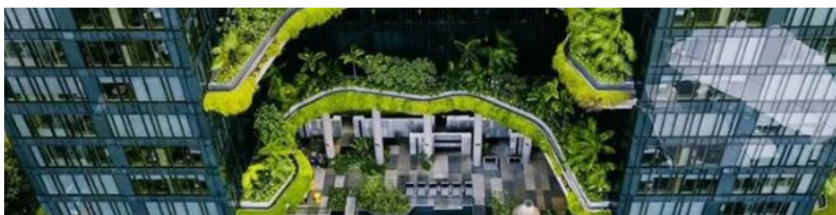
Figura 4.19. Eco Building em Singapura. Presença de grandes aberturas e vegetação trazem equilíbrio térmico - Fonte: https://www.pinterest.pt/pin/124974958396104788/ Consultado em 06 de abril de 2020
