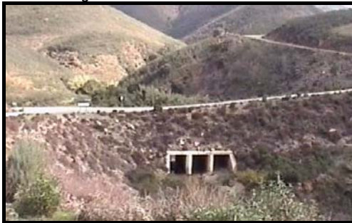
Figura 5 - Passagem hidráulica situada a 190 m do corpo da barragem
