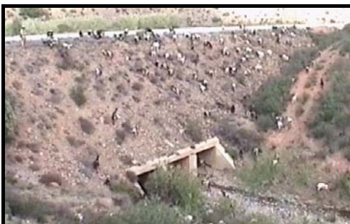
Figura 6 - Passagem hidráulica situada a 3097 m do corpo da barragem
