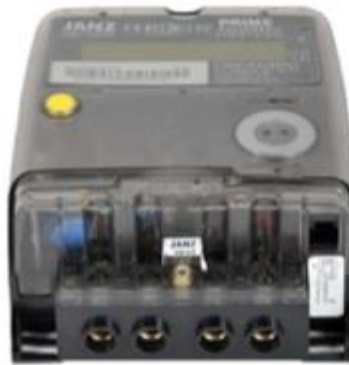
Figure 5.4 – The smart meter, e-box, being installed by the EDP Distribuição. [21]
