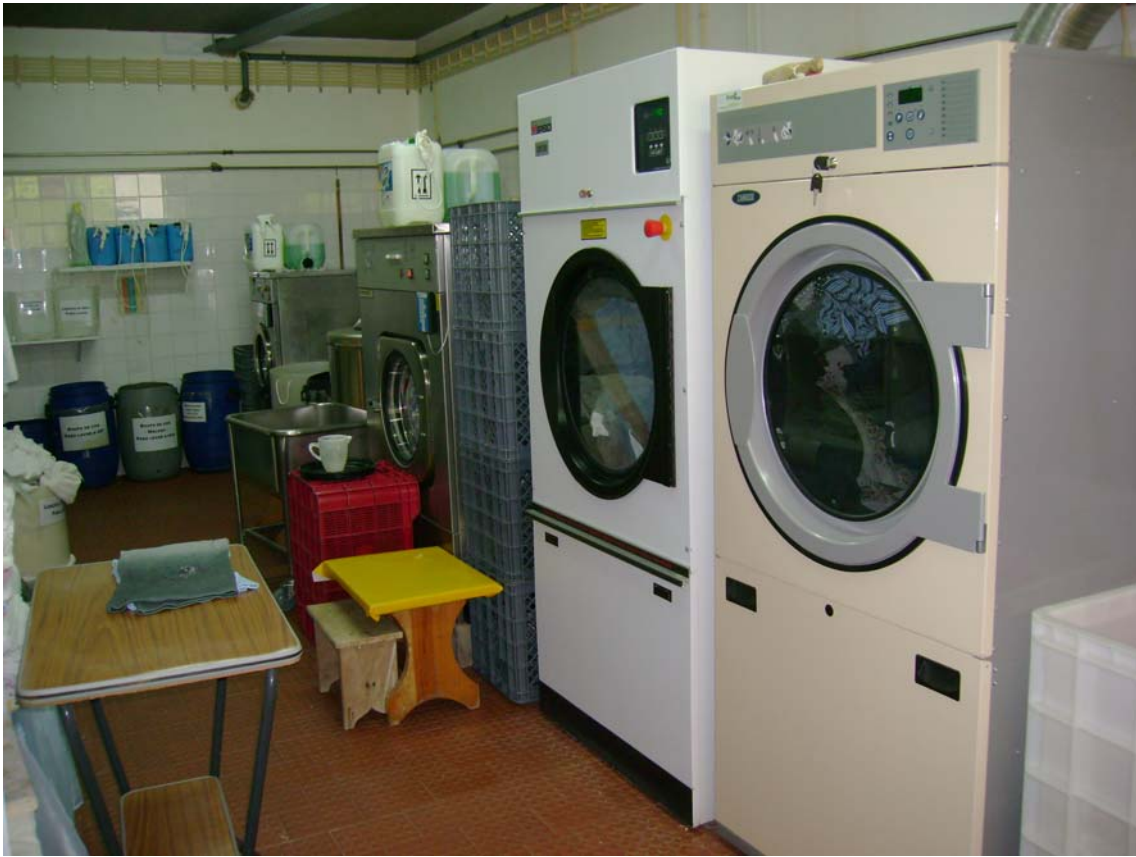
Fotografia 11 - Lavandaria (secção das máquinas)
