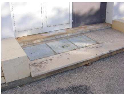
Vista exterior da zona de manobra do átrio A11
