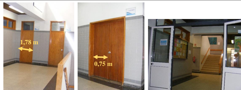
Portas de salas de aula, do auditério e do corredor
