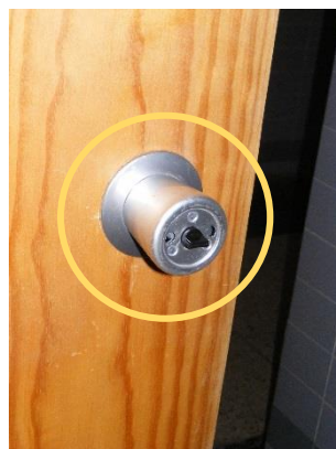
Puxador da porta da instalação sanitária
