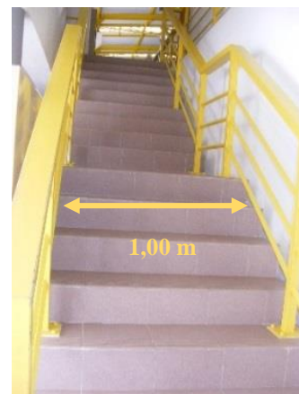
Escada do pavilhão
