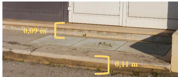
Altura do ressalto da porta do átrio A11
