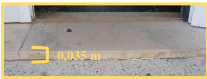
Altura do ressalto da porta do átrio A2
