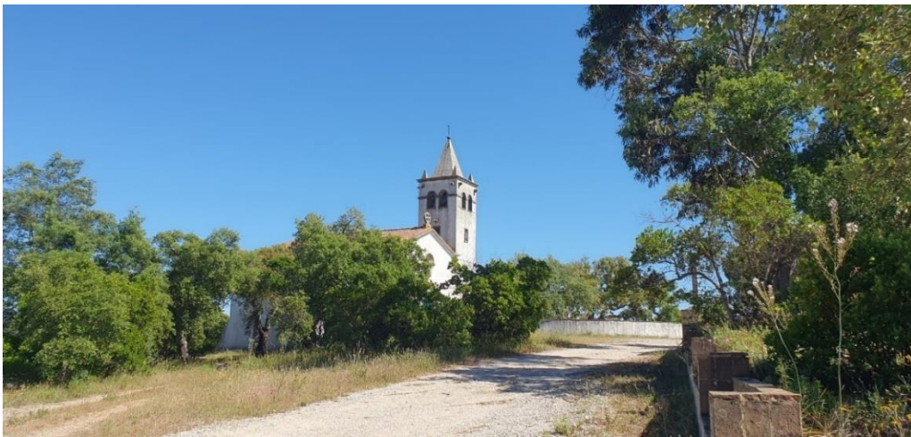
Figura 5.1 – Igreja Matriz do Barranco do Velho (Fonte: foto tirada durante visita de campo)
