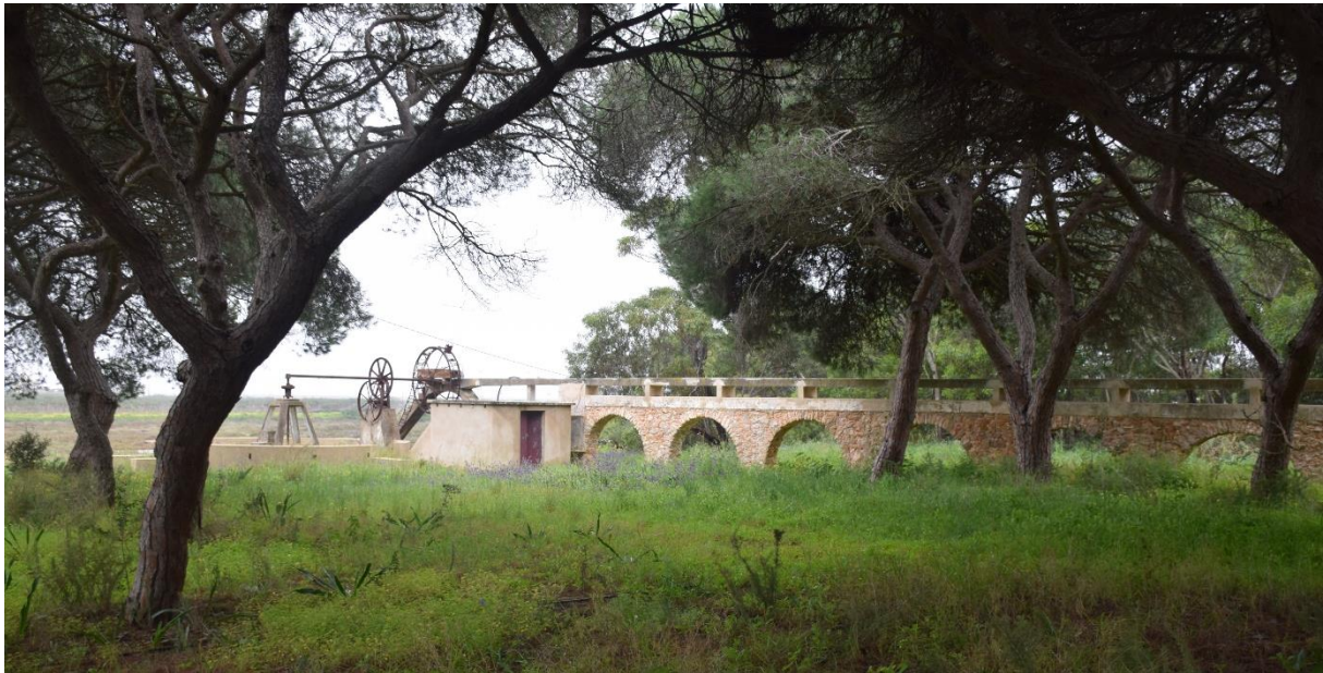
Figura 5.12 – O aqueduto em alvenaria de pedra com canal quadrangular sobreposto em betão armado. (Fotografia de Miguel Reimão Costa).
