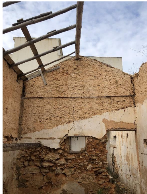
Figura 5.10 – Pormenor do cabo de ferro instalado para contrariar a abertura das paredes perimetrais do palheiro (fotografia de Filipe Lacerda Neto).
