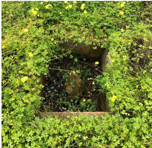
Figura 5.14 – Caixas situadas nos pontos de bifurcação dos canais subterrâneos de irrigação (fotografias de Filipe Lacerda Neto).
