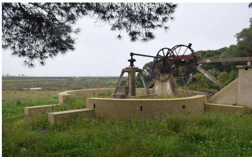
Figura 5.11 – Passeio do gado sobrelevado, com dupla rampa de acesso (fotografia de Miguel Reimão Costa).
