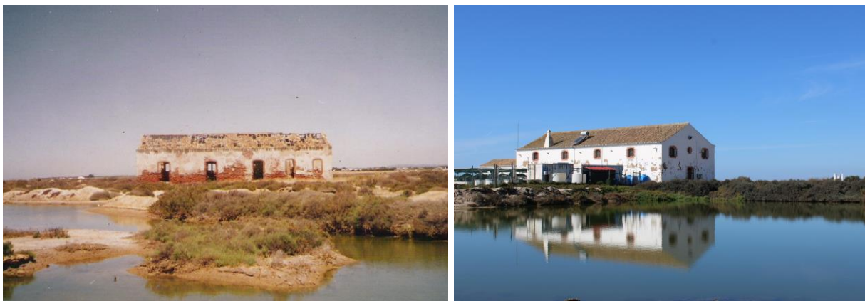
Figura 4.13 – À esquerda, Imagem do Ramalhete em ruínas antes das obras de intervenção (CCMAR, 2021); à direita, Estação marinha do Ramalhete no estado atual (fotografia da autora).
