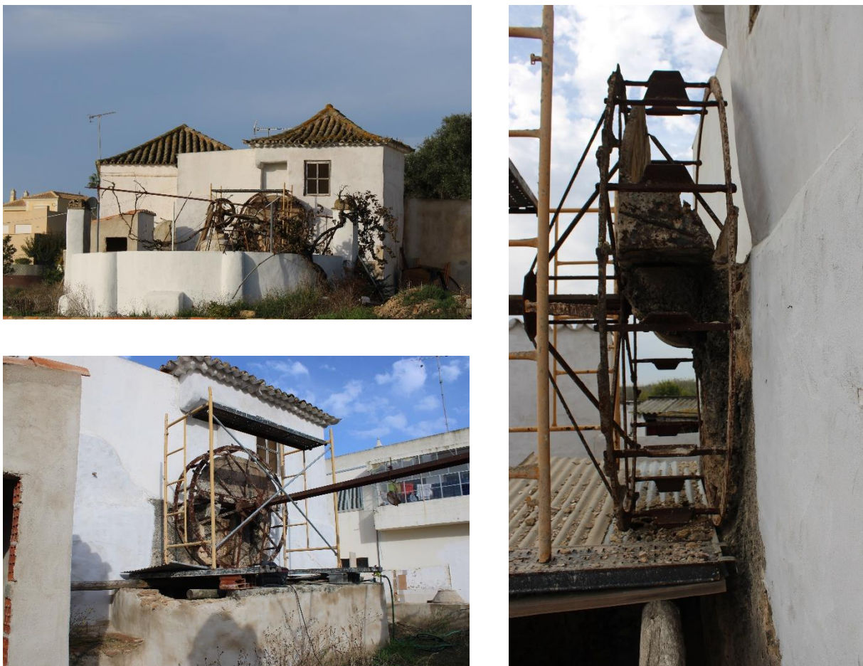
Figura 5.7 – Em cima à esquerda, fotografia do conjunto 2; em baixo à esquerda, poço da nora com a roda da água; à direita, detalhe da roda de água que está ancorada diretamente à parede da casa. (Fotografias da autora).
