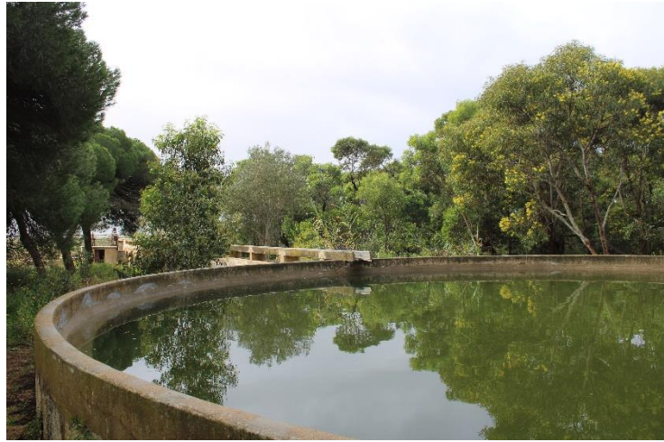
Figura 5.13 – Tanque de forma circular em alvenaria de pedra (fotografia da autora).
