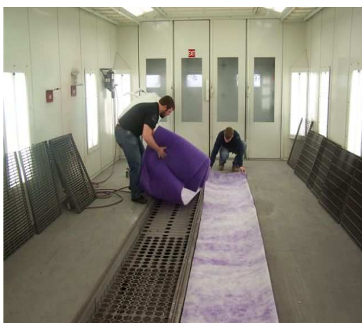
Ilustração 8 – Aplicação de filtros tipo rolo
