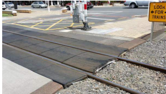
Fig. 7. Exemplo de revestimento em painel de borracha numa passagem de nível
