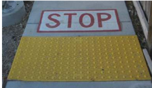
Fig. 3. Marcação de pavimento “STOP”
