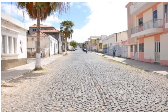
Figura 16 – Alinhamento de rua – Vila
