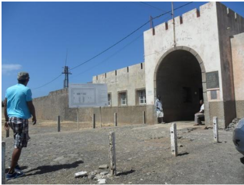
Figura 3 – Entrada Prisão Chão Bom
