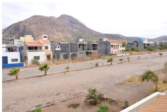
Figura 17 – Alinhamento de rua – Ponta d' Atum
