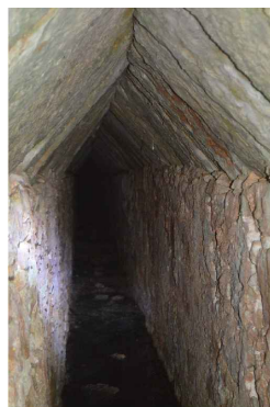
I2 - Interior da Mina
