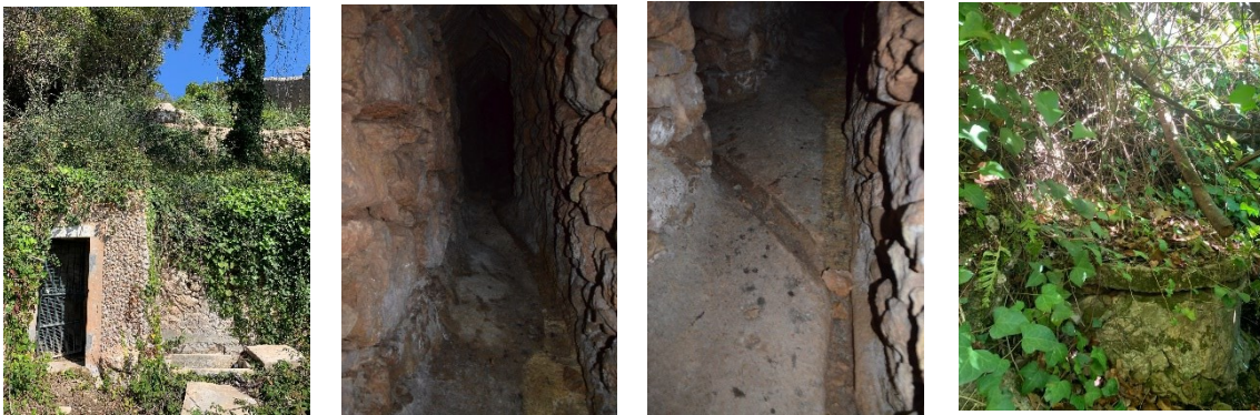
Figura 49 - Entrada da Mina 1, interior e poço de respiração. Fonte: Paula Medeiros.
