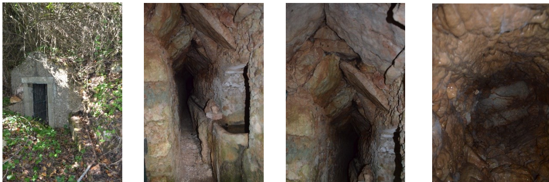
Figura 53 - Entrada da Mina 3, interior e poço de captação. Fonte: Paula Medeiros.
