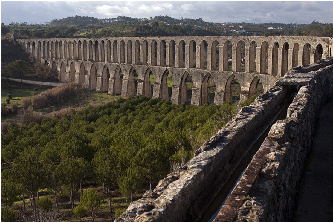
Figura 39 - Aqueduto do Convento de Cristo. Fonte: Eduardo Lima.
