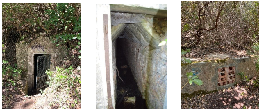
Figura 55 - Entrada da Mina 4, interior e poço de respiração. Fonte: Paula Medeiros.
