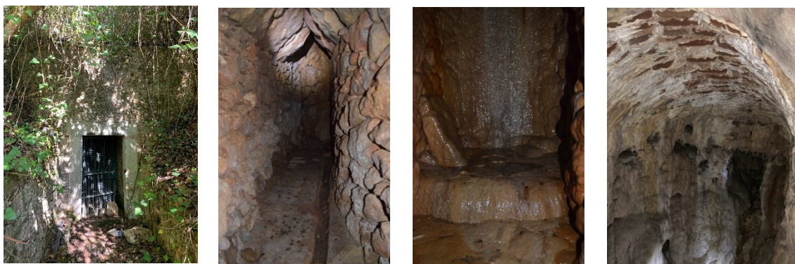
Figura 51 - Entrada da Mina 2, interior, poço de captação e cobertura abobadada de tijolos burros. Fonte: Paula Medeiros.
