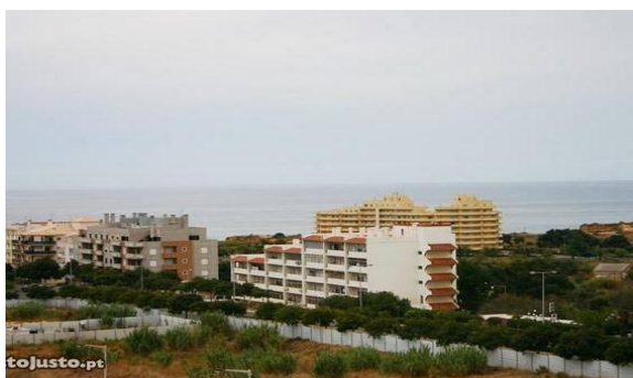
Figura 1.2.: Prédio Urbano na Praia da Rocha em Portimão
