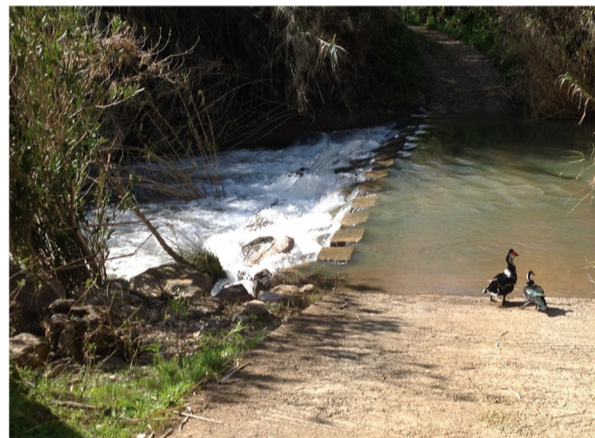
4 Travessia existente entre margens sobre o rio Sêqua/Gilão
