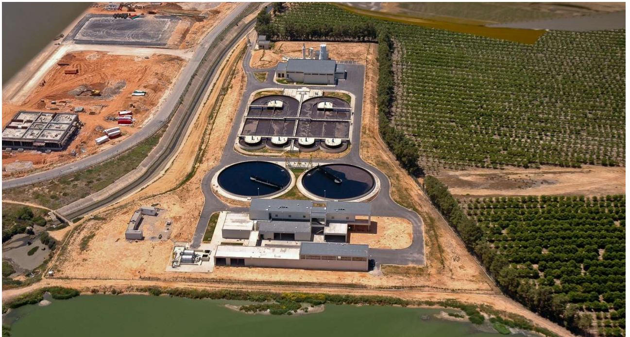
Figura I.8 - ETAR Faro Noroeste (cedido por Águas do Algarve).
