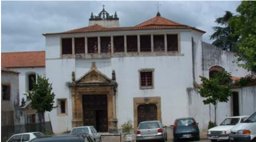
Figura 4- Santa Maria de Celas, fachada principal.
