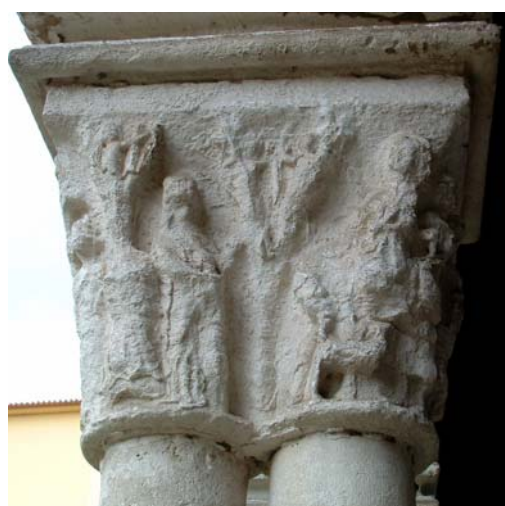
Figura 34 - Capitel 6, Entrada de Cristo em Jerusalém (c), pedra degradada.
