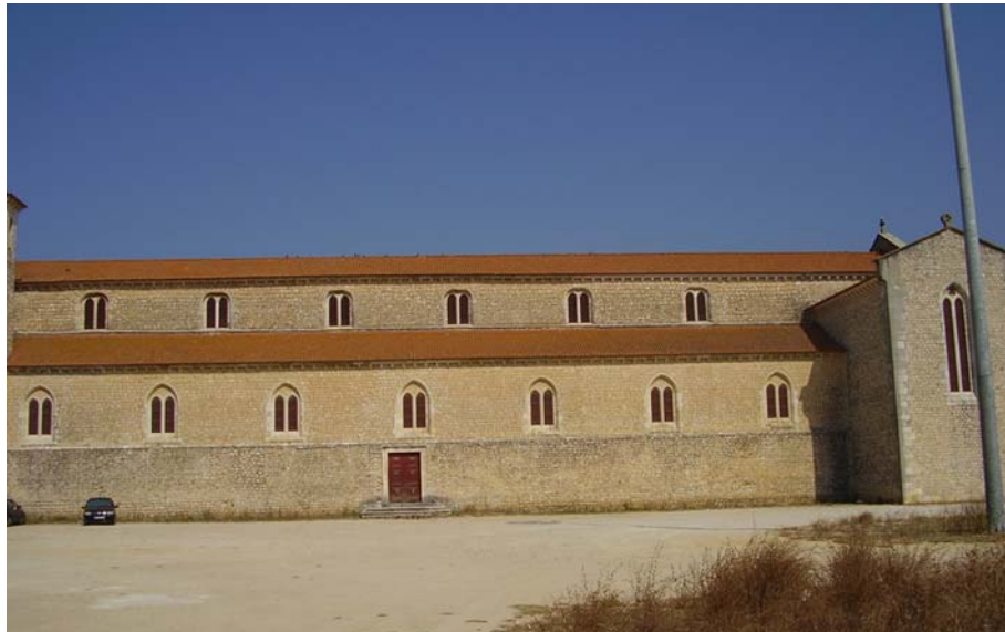
Figura 124- Santa Clara de Santarém, fachada lateral.
