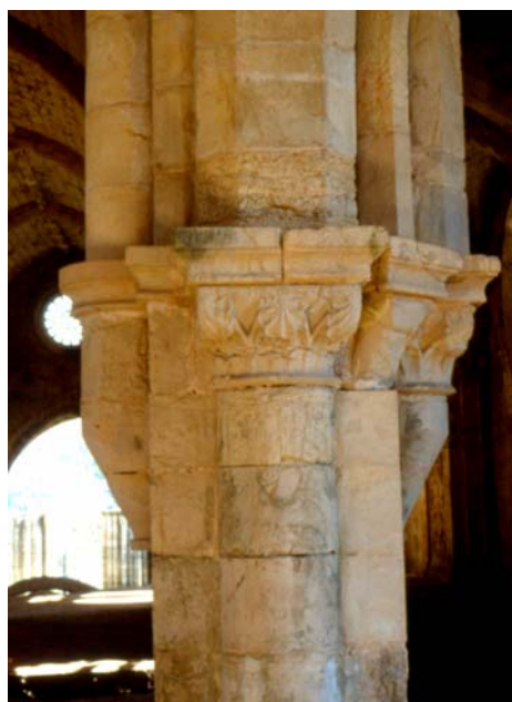
Figura 157- Santa Clara de Coimbra, pilar da igreja.
