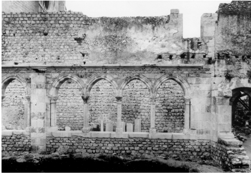
Figura 113- Santa Maria de Almoester, claustro, galeria da leitura (DGEMN).
