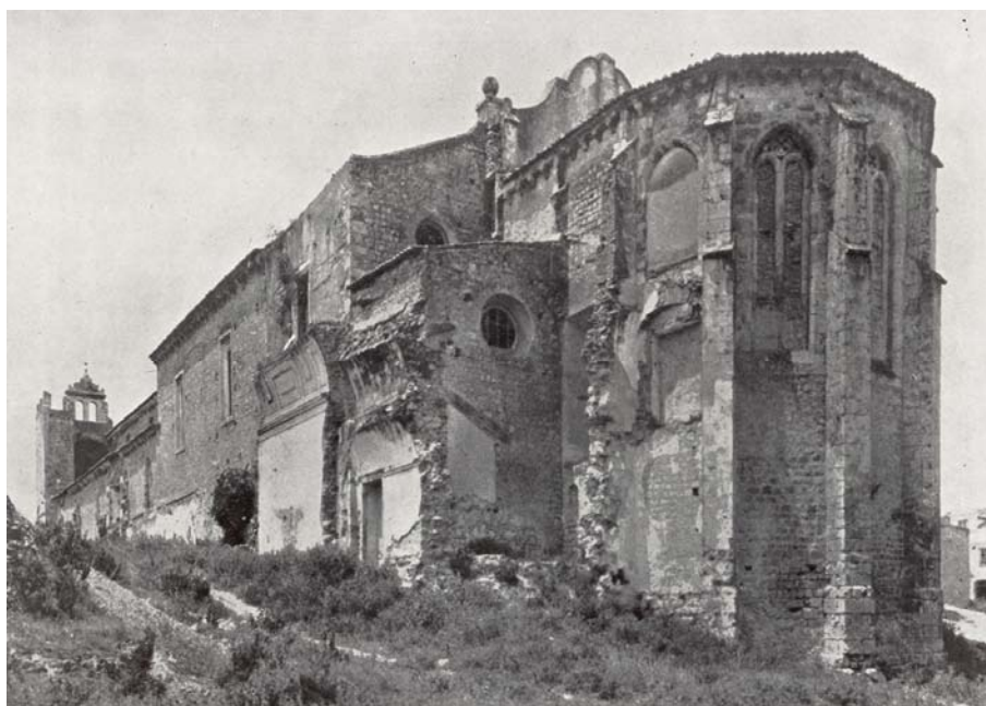
Figura 120- Santa Clara de Santarém, igreja antes das obras de restauro (DGEMN).
