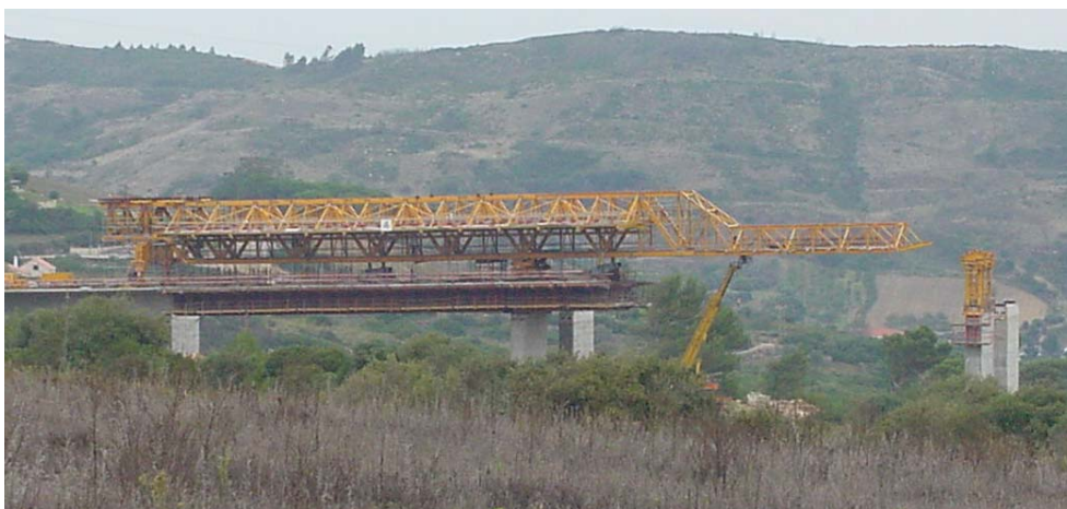
Figura 7 – Cimbre auto-lançável superior em deslocação para uma nova posição
