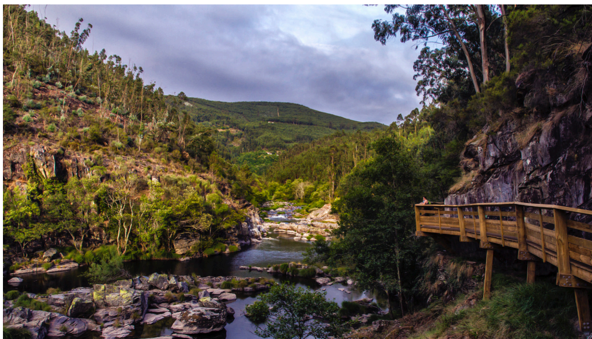
Figura 2.13 - Imagem dos Passadiços do Paiva localizados na margem esquerda do Rio Paiva. Passadiços do Paiva - Arouca, 2019.
