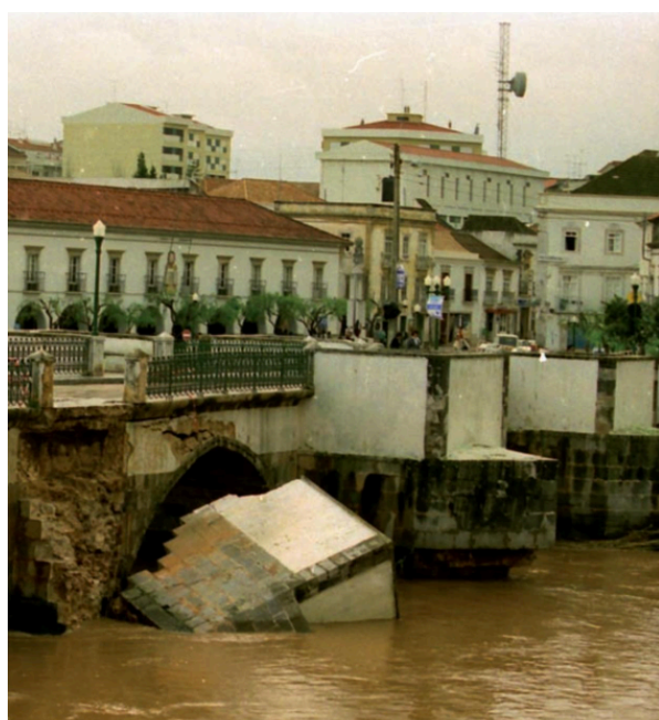
Figura 3.32 - Destruição da ponte romana causada pelas cheias da década de 89. Retirado de: https://issuu.com/museum_tavira/docs/fotografar
