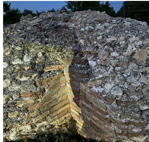
Figura 2.2 Pormenor das paredes do edifício de cultos construído com tijolos e opus caementicium
