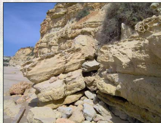
Queda de Blocos
