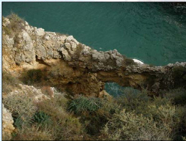
Arcos resultantes do abatimento da parte inferior da arriba
