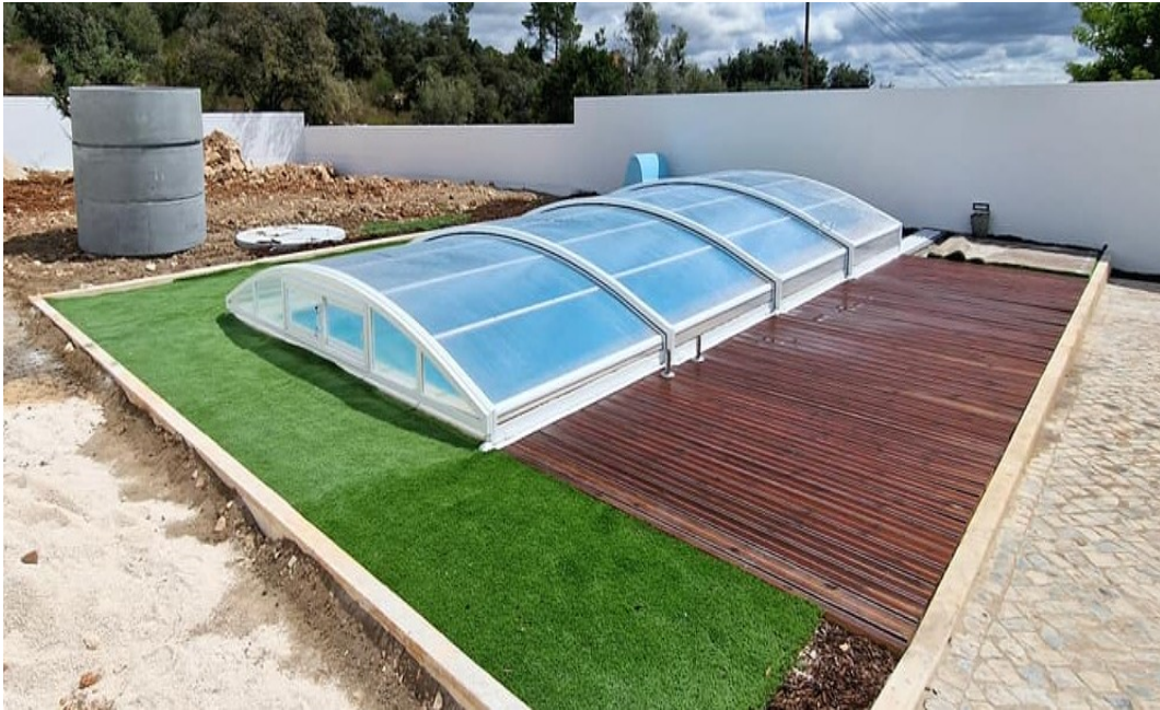
Figura 48 - Cobertura telescópica baixa – Fotografia cedida pelo Sr. Ricardo Lopes (22/09/2022)
