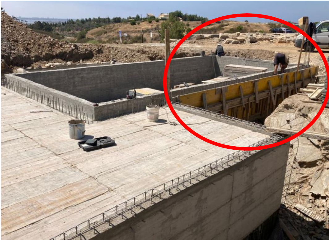
Figura 8 - Cofragem de uma piscina – Fonte própria (17/01/2023)
