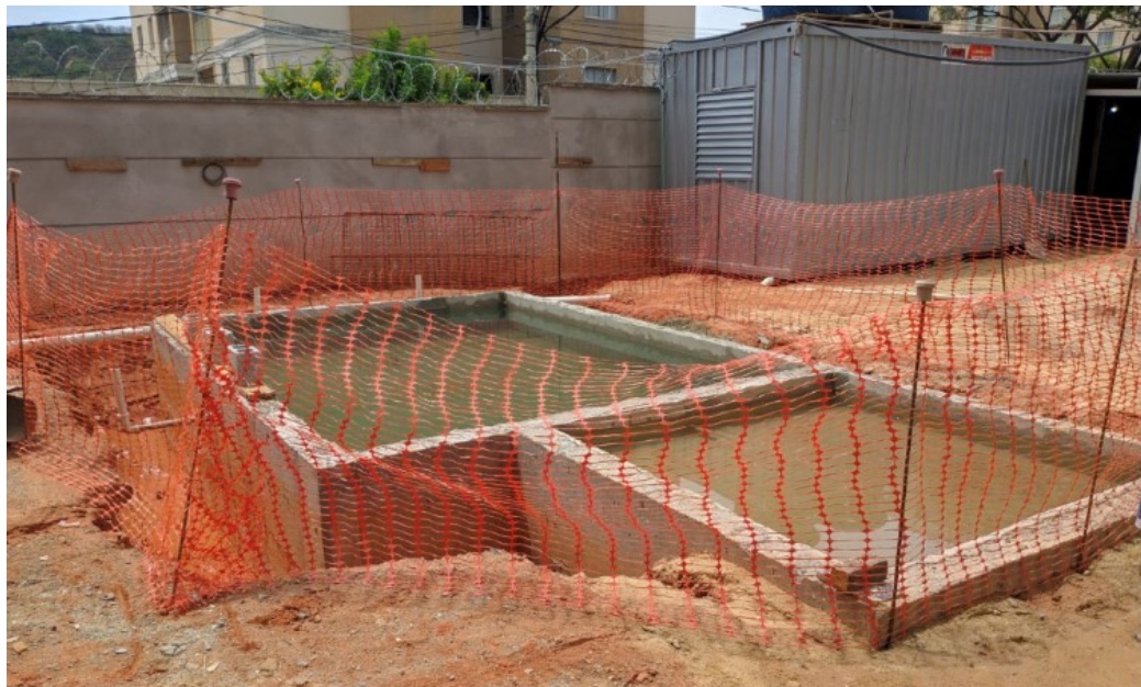
Figura 17 - Teste de impermeabilização – Fonte própria (28/02/2022)
