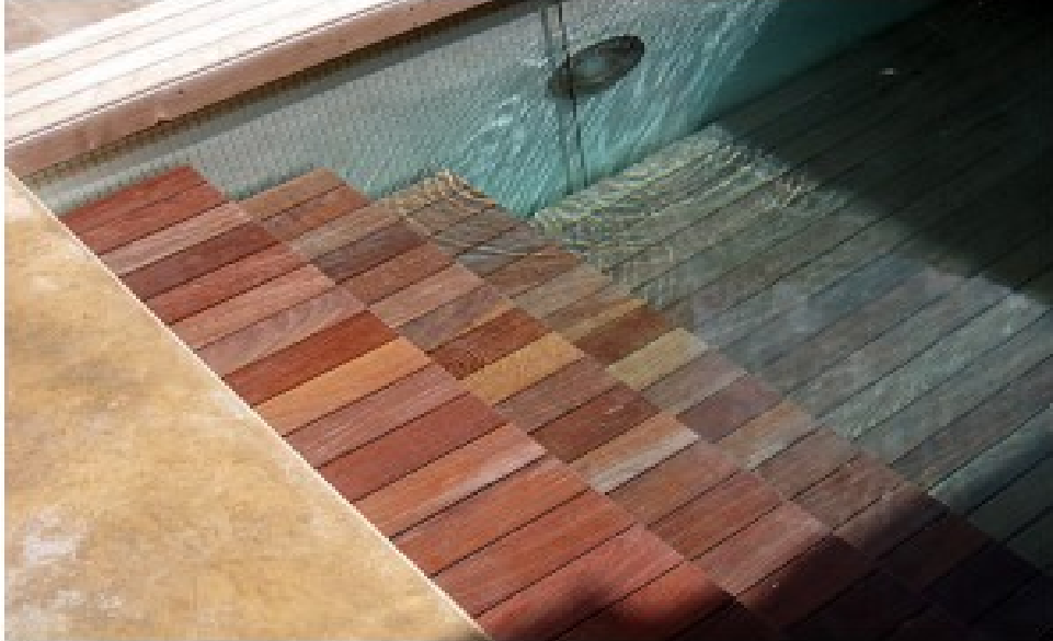
Figura 42 - Cobertura (na sua posição final recolhida (Silva, 2018))
