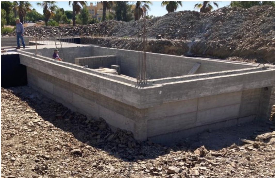
Figura 9 - Piscina já betonada e descofrada – Fonte própria (17/01/2023)
