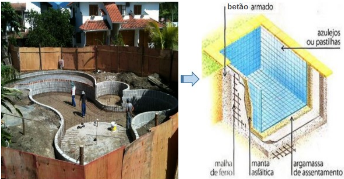
Figura 63 - Piscina em betão armado (Fonseca, 2018)
