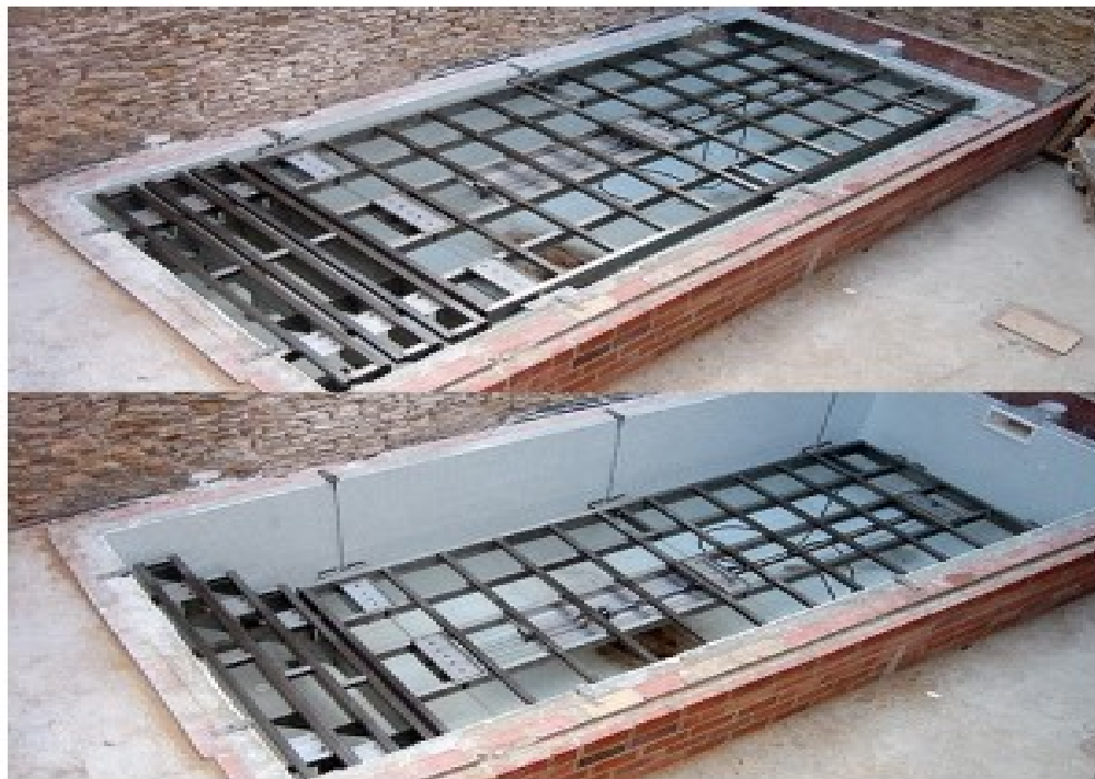
Figura 41 - Estrutura da cobertura (Silva, 2018)
