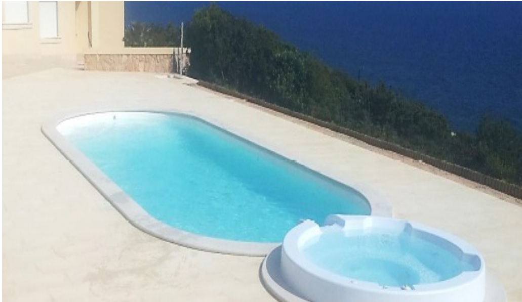
Figura 24 - Enchimento da piscina (Algarve Pools, 2022)
