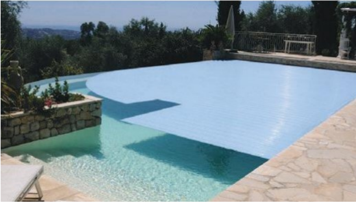
Figura 72 - Cobertura lamelar submersa imagem (Living Pool, 2022)
