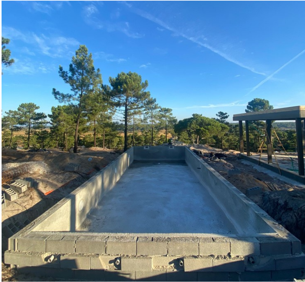
Figura 11 - Piscina em betão projetado, com cofragem perdida em alvenaria – Fonte própria (24/01/2023)
