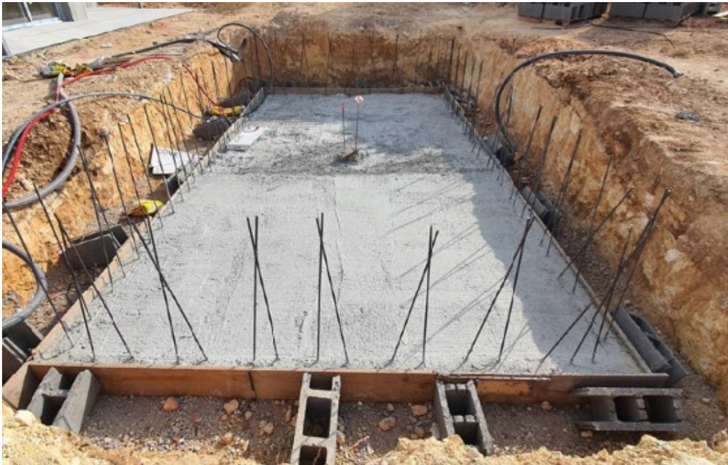
Figura 30 - Betonagem do pavimento – Fotografia cedida pelo Sr. Francisco Carmo (26/01/2023)
