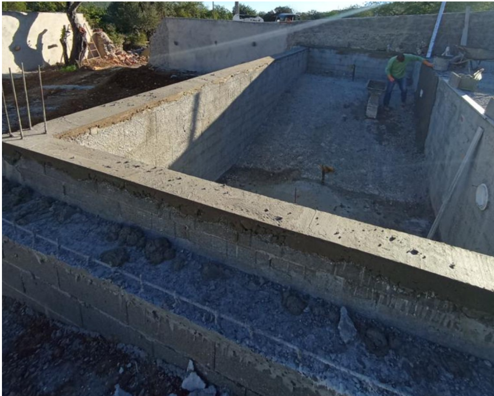
Figura 66 - Piscina em alvenaria a receber o reboco – Fonte própria (07/02/2022)
