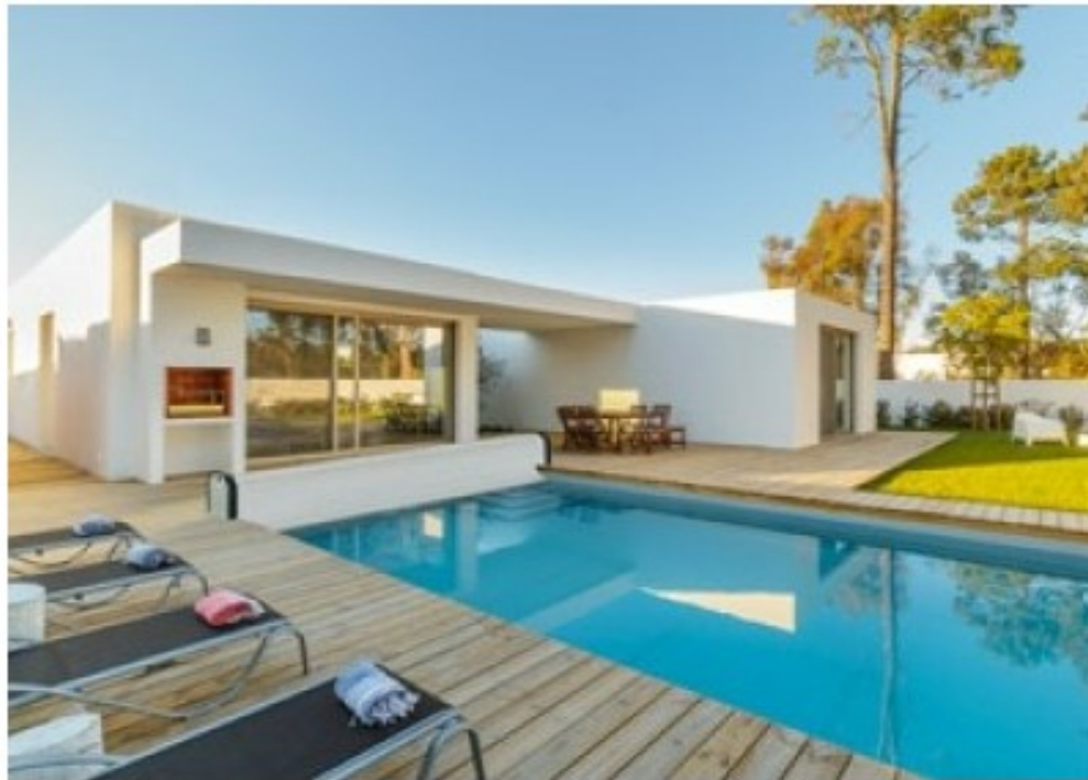
Figura 44 - Cobertura lamelar com a caixa do enrolador sobre o solo – Modelo 02 (Abrisud, 2022)
