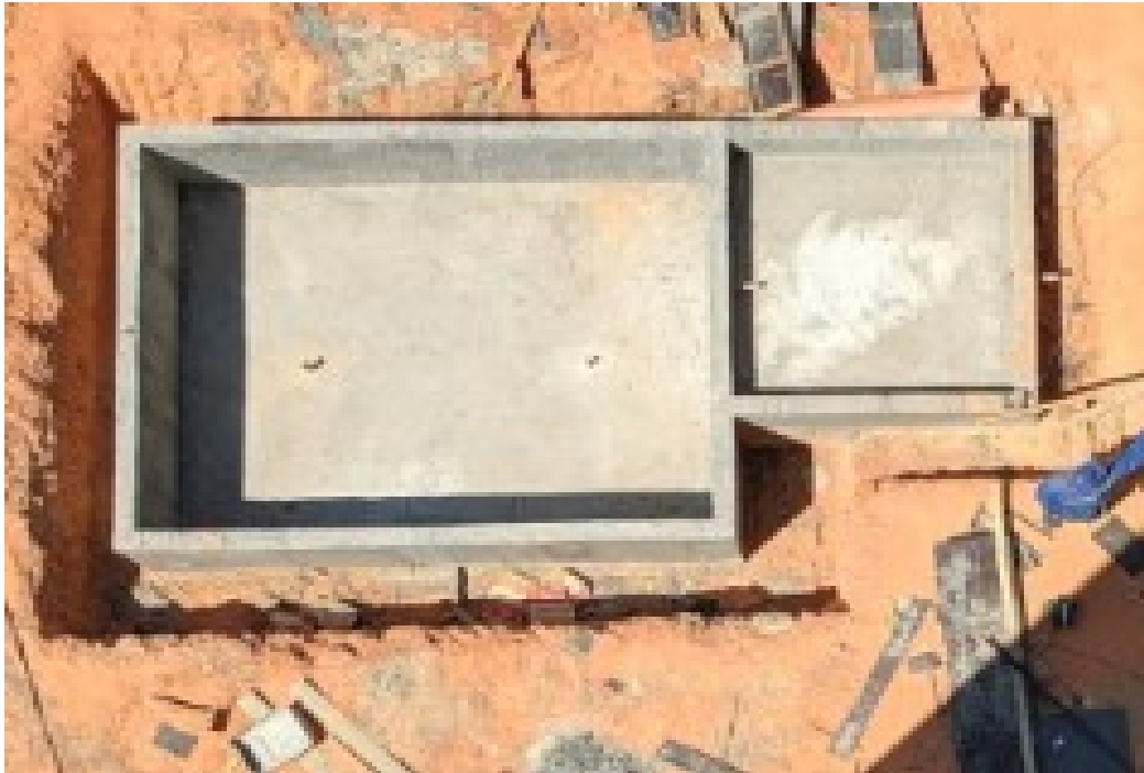
Figura 16 - Alvenaria rebocada – Fonte própria (25/02/2022)
