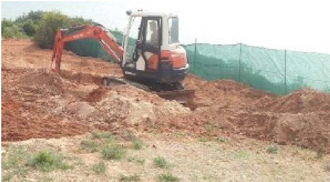
Figura 21 - Preparação do terreno e escavação do buraco do tanque (Algarve Pools, 2022)
