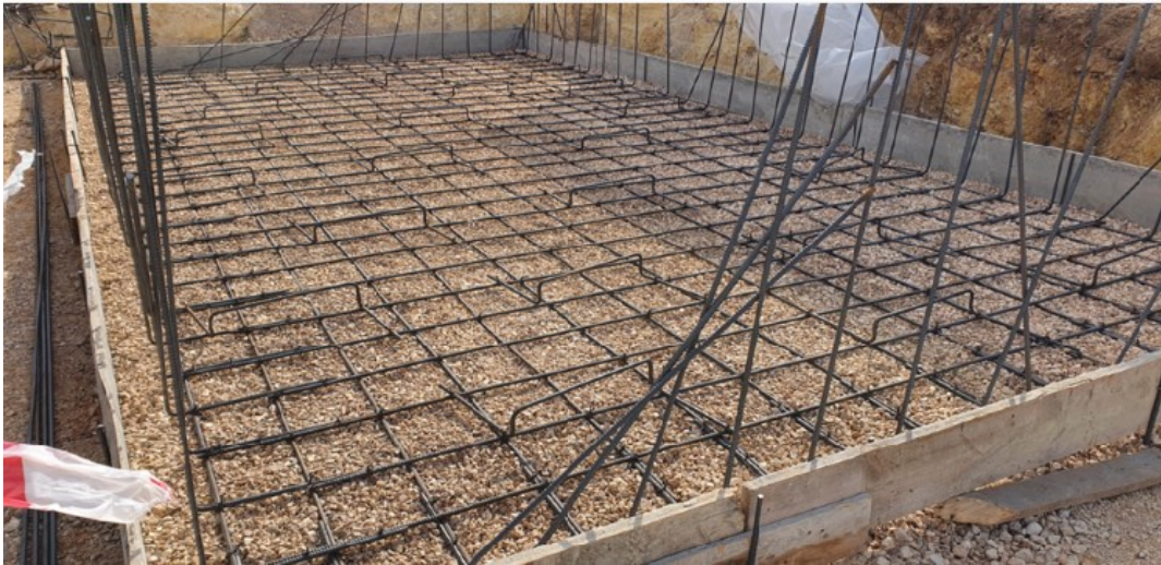
Figura 29 - Preparação do pavimento para betonagem – Fotografia cedida pelo Sr. Francisco Carmo (26/01/2023)
