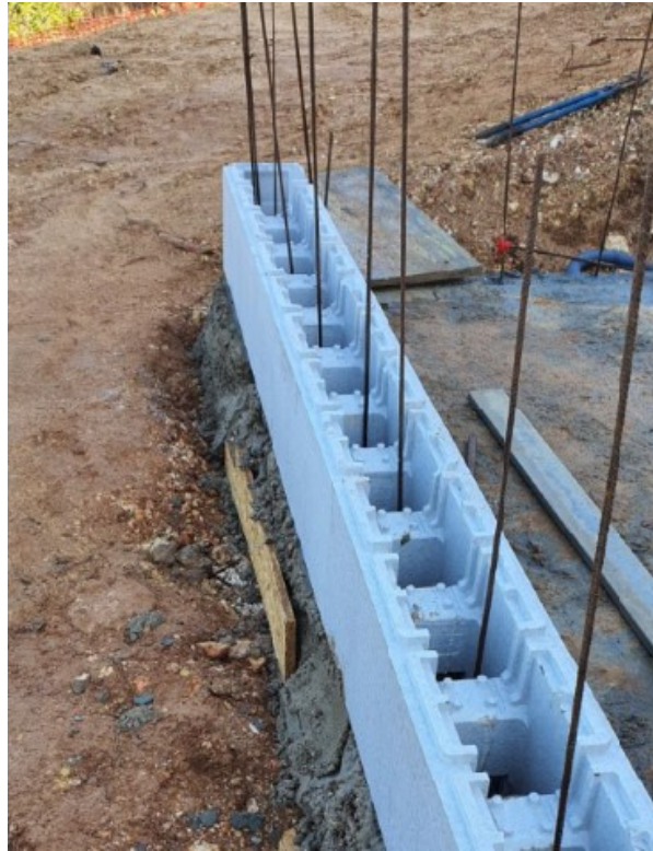
Figura 31 - Montagem do sistema de blocos em EPS - Fotografia cedida pelo Sr. Francisco Carmo (26/01/2023)
