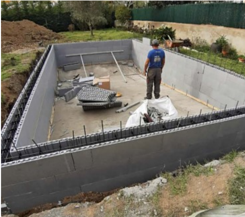
Figura 28 - Piscina térmica com cofragem em blocos de EPS (Grupo Cypsa, 2021)
