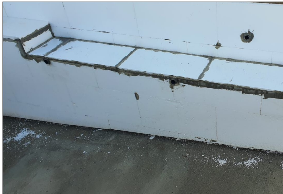
Figura 61 - Aplicação de ETICS nas paredes do tanque da piscina – Fonte própria (18/10/2022)
