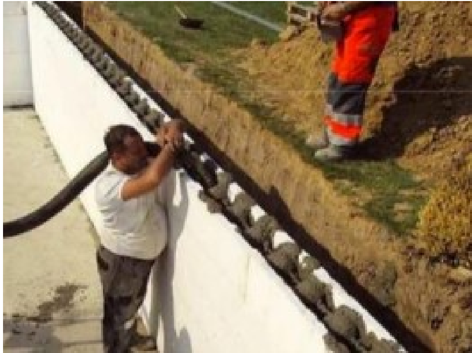
Figura 33 - Betonagem dos blocos (Poliurea Systems)
