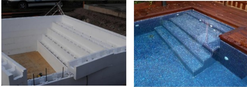
Figura 70 - Estrutura de piscina em blocos de EPS e piscina já finalizada com acabamento (Poliurea Systems)
