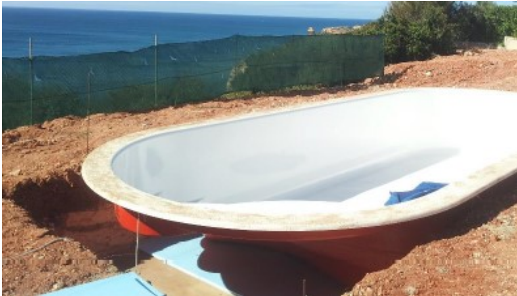
Figura 23 - Instalação de piscina no local (Algarve Pools, 2022)
