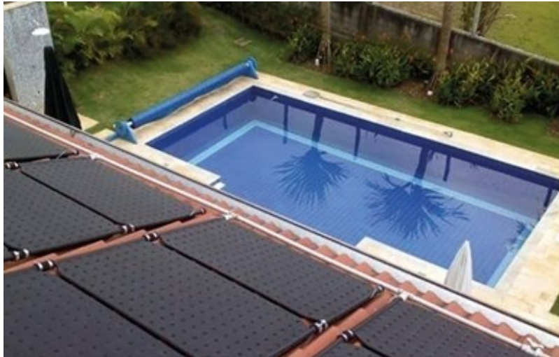
Figura 59 - Painéis fotovoltaicos (ENAT Energias, 2022)
