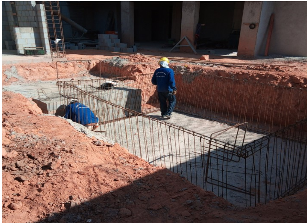
Figura 14 - Piso em betão armado e armaduras para alvenaria – Fonte própria (26/02/2022)
