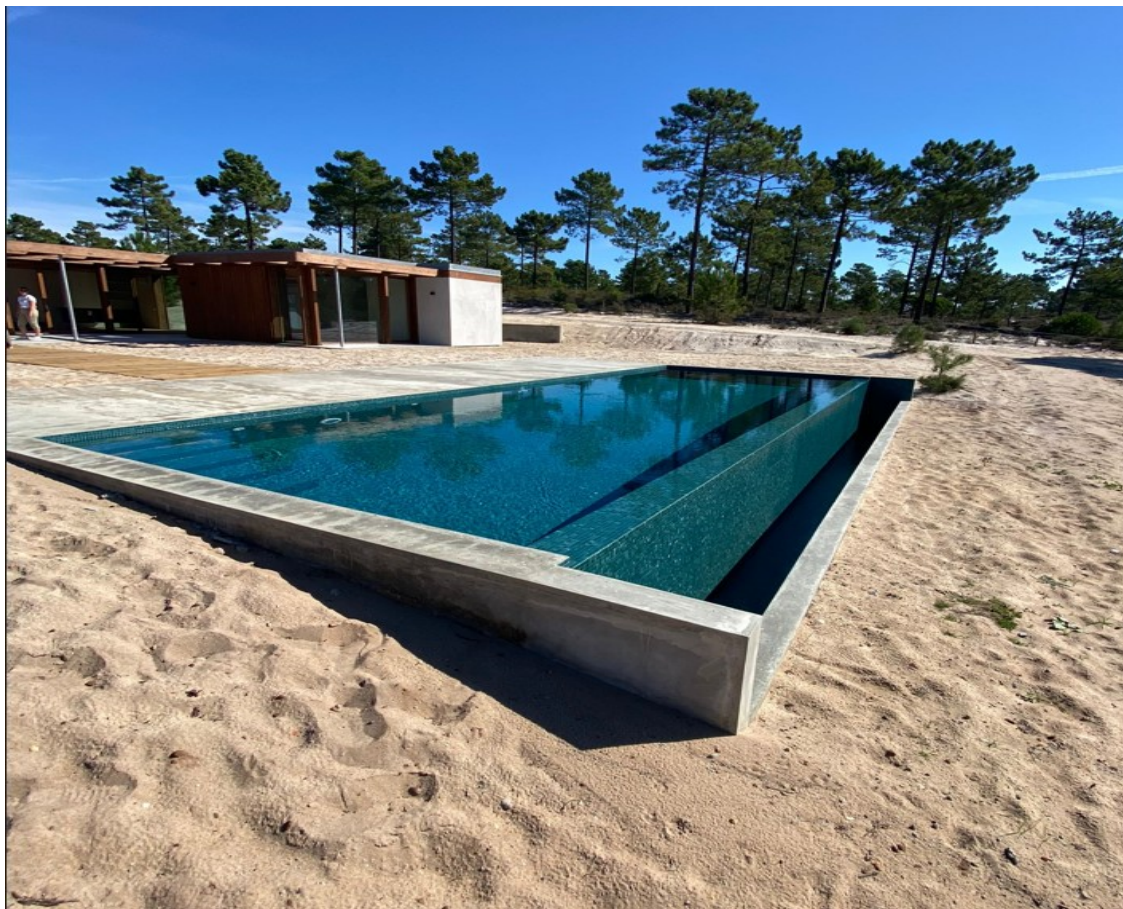
Figura 65 - Piscina em betão projetado, com cofragem perdida em alvenaria – Fonte própria (13/01/2023)
