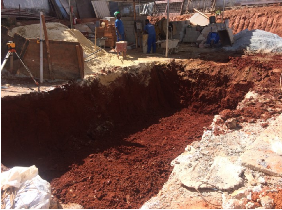
Figura 7 - Escavação de piscina – Fonte própria (28/02/2022)
