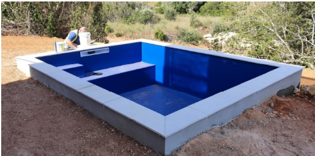
Figura 34 - Piscina com finalização de revestimento - Fotografia cedida pelo Sr. Francisco Carmo (17/05/2021)
