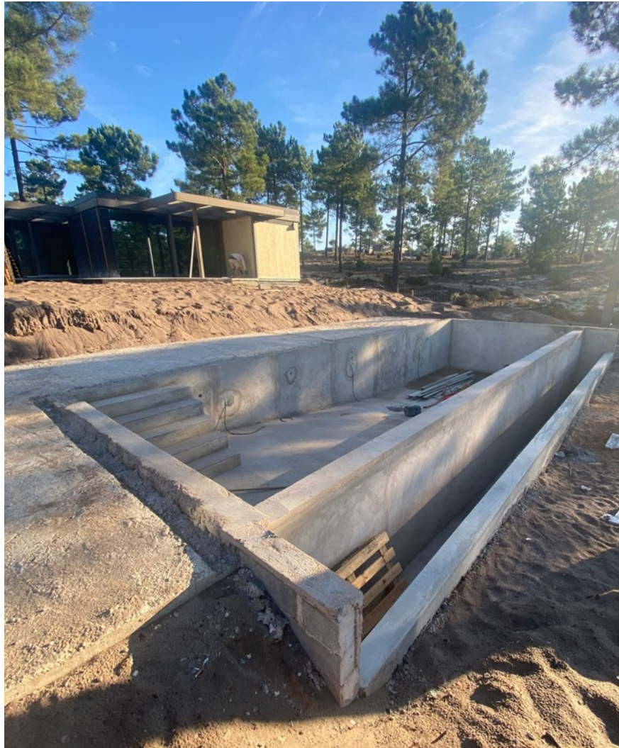
Figura 12 - Piscina em betão projetado, com cofragem perdida em alvenaria e tanque de compensação – Fonte própria (24/01/2023)
