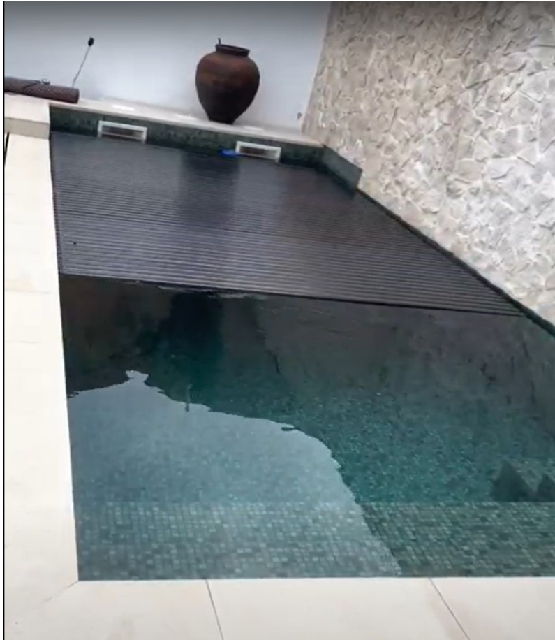
Figura 47 - Cobertura lamelar submersa colocada – Fonte própria (09/12/2022)
