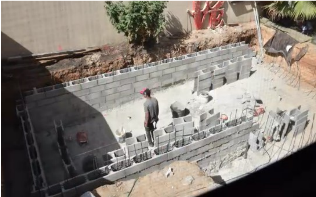
Figura 15 - Execução da alvenaria de uma piscina – Fonte própria (25/02/2022)
