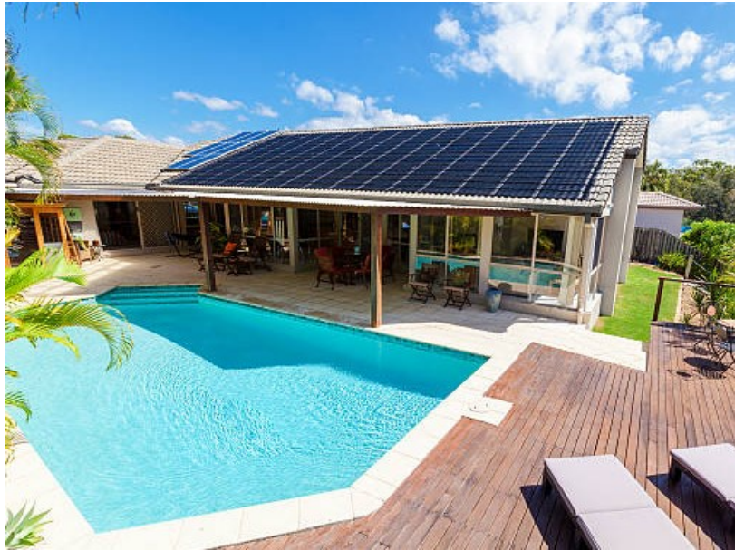
Figura 58 - Coletores solares para piscinas (Tholz, 2022)
