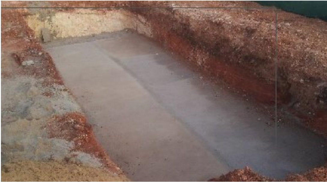
Figura 22 - Execução de base em betão (Algarve Pools, 2022)
