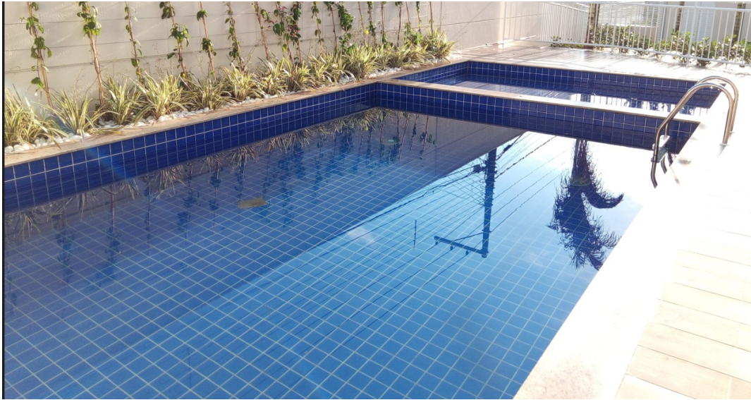
Figura 10 - Piscina em betão finalizada – Fonte própria (23/02/2023)
