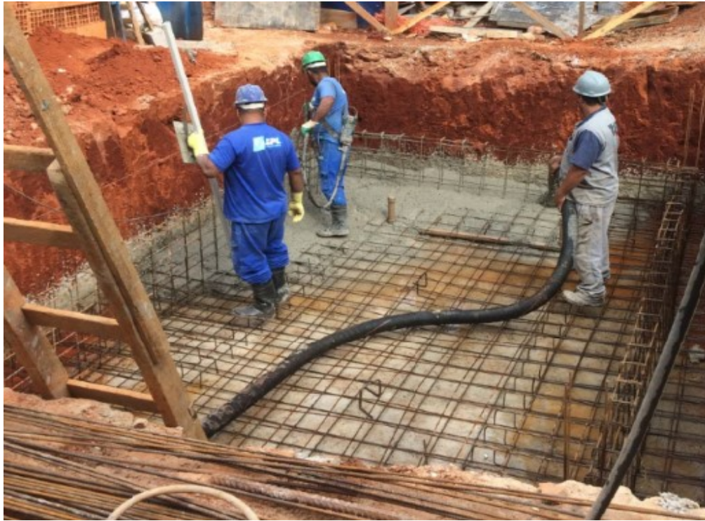
Figura 13 - Betonagem do piso da piscina – Fonte própria (26/02/2022)
