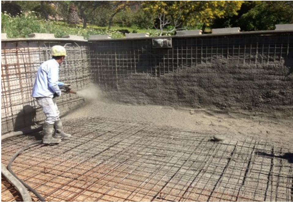
Figura 64 - Piscina em betão projetado – Fonte própria (15/01/2023)
