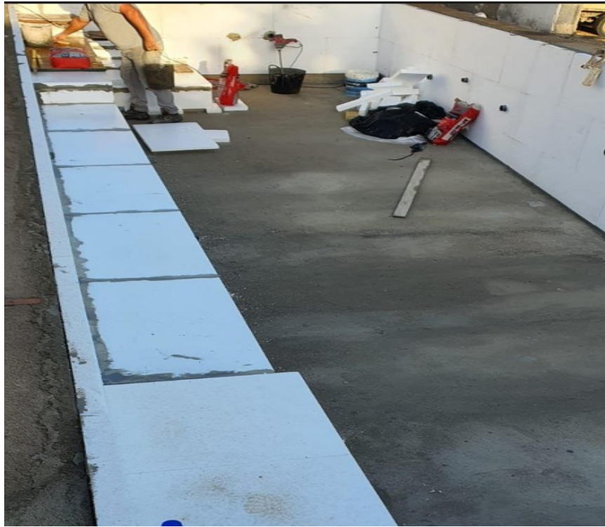
Figura 62 - Aplicação do isolamento das paredes do tanque da piscina – Fonte própria (18/10/2022)
