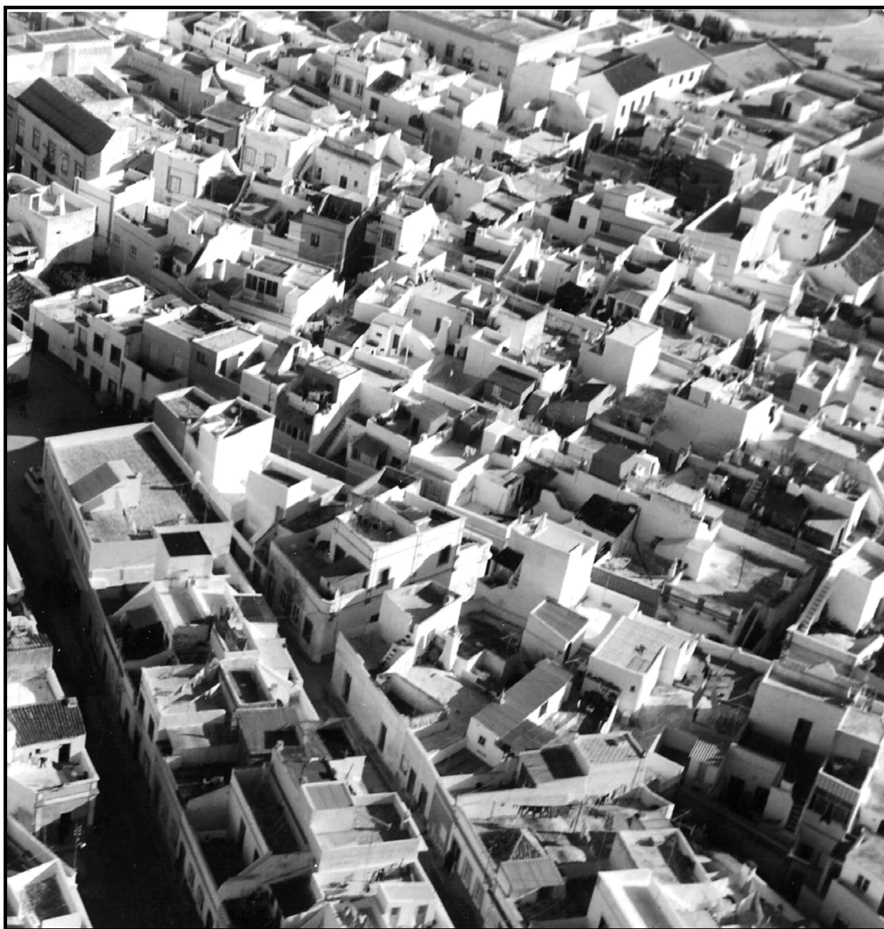
fig. 40 Fotografia aérea da Barreta. Os mirantes foram substituídos por pequenas divisões com cobertura de zinco. O cenário é caótico. (A.H.M.O.)
