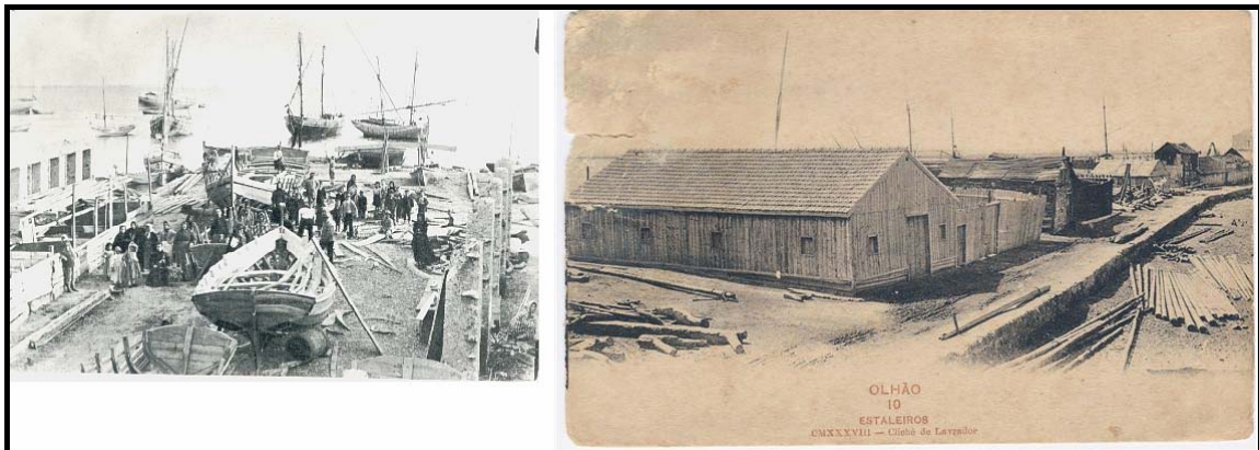
fig. 56 Estaleiros de construção naval situados junto à Barreta. O primeiro era propriedade do mestre João da Carma e o segundo era propriedade dos irmãos e mestres José e António da Graça. (fotos do A.H.M.O.)
