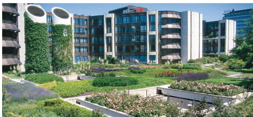
Figura 3.14- Cobertura Verde Intensiva simples, Basel, Suíça (Fonte: ZINCO, 2016)
