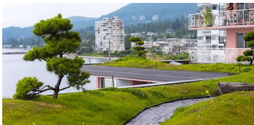
Figura 3.13- Cobertura Verde Intensiva, Este de Vancouver (Fonte: ZINCO, 2016)
