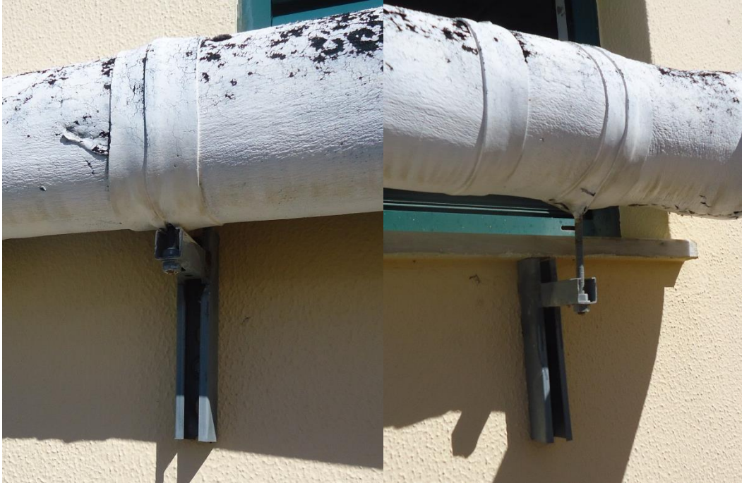
Figura 14 – Apoio da tubagem de climatização.
