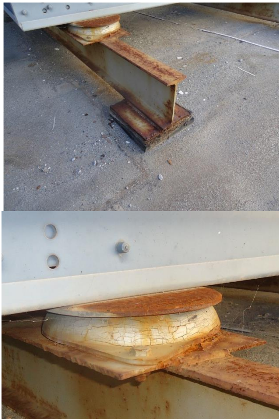
Figura 20 – Apoio do chiller.
