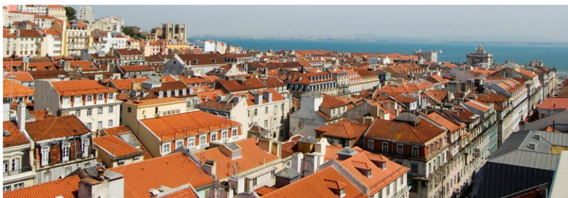
Figura 57: Imagem geral dos telhados da Baixa Pombalina Fonte: Soares/ENERONE, 2010
