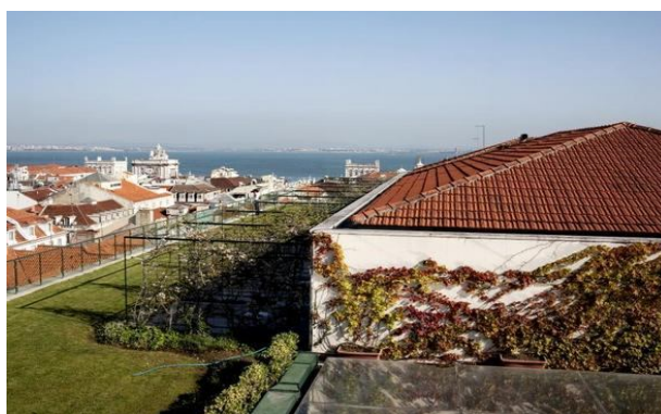
Figura 54: Telhado verde do Hotel Lisboa Regency Fonte: www.lisboaregencychiado.com
