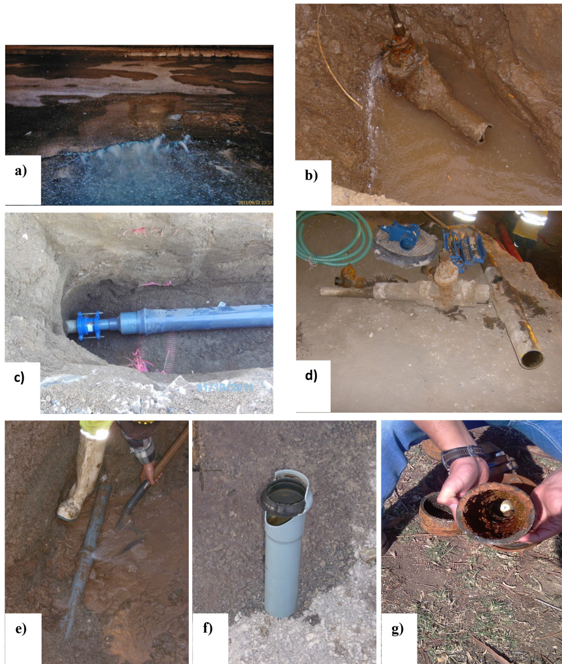
Figura 3.3: Fotografias demonstrativas das incidências mais comuns na rede de distribuição de Reguengos de Monsaraz (a), b) e f) – roturas de água nas condutas de água; b), c) e d) – inoperacionalidade de órgãos de manobra, idade das condutas e natureza; c) – subdimensionamento da rede de distribuição de água; g) biofilme nas paredes das condutas de água)
