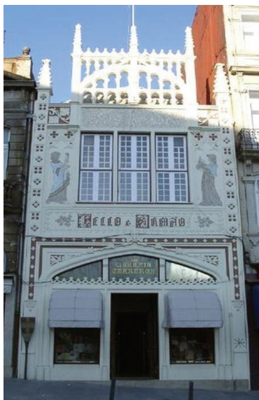
Figura 5: Fachada da Livraria Lello
