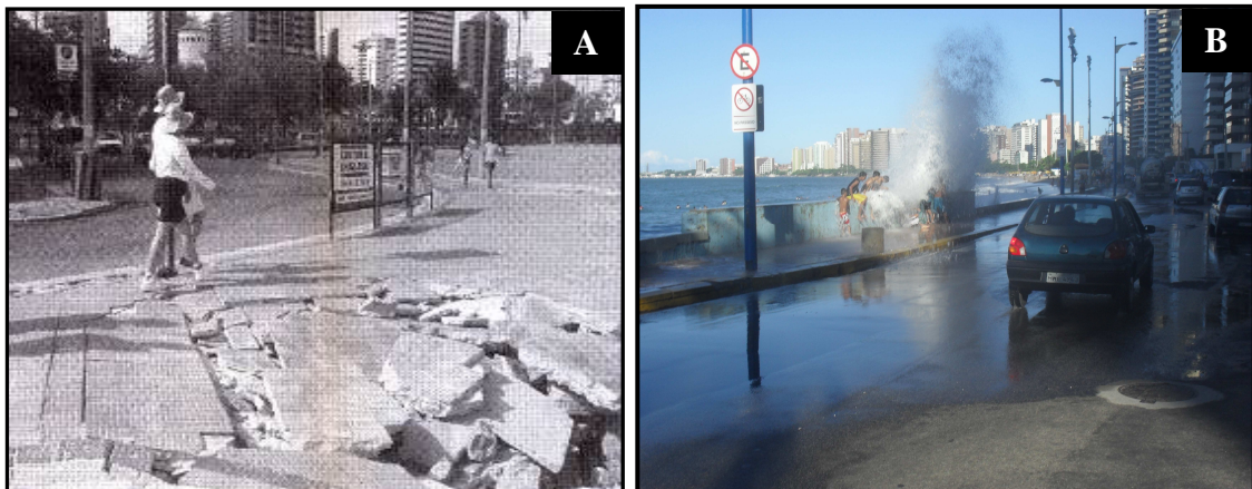
Figura 3.21 - A) Em 3 de dezembro de 1999, a ressaca do mar provocou danos no calçadão da orla; B) Em 19 de março de 2011 as ondas de ressaca galgaram as estruturas urbanas e atingiram a Avenida Beira-Mar. Foto: A) Jornal Diário do Nordeste.
