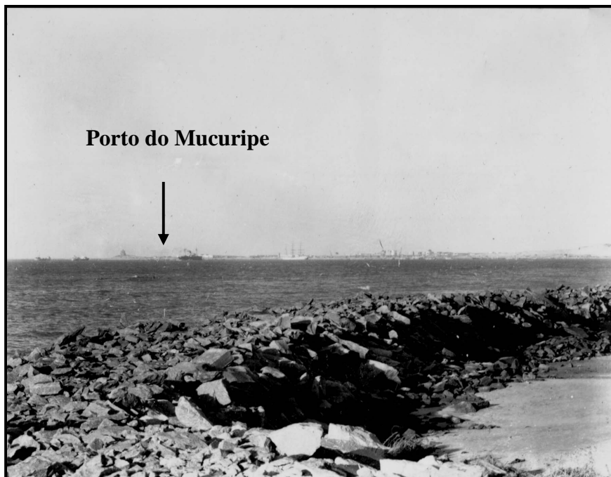
Figura 4.26 - Vista do Porto do Mucuripe a partir do enrocamento construído por Chermont para conter a erosão na Praia de Iracema em 1938. Fonte: Acervo do IBGE – Registro 10305, Foto de Stivan Faludi, negativo 4795.
