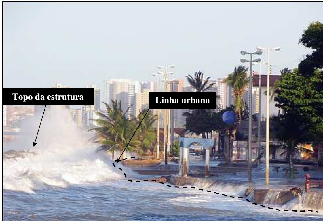
Figura 7.6 - Ondas de ressaca galgando o enrocamento de proteção da Praia de Iracema em 2005. Foto de Rapha Bessa.
