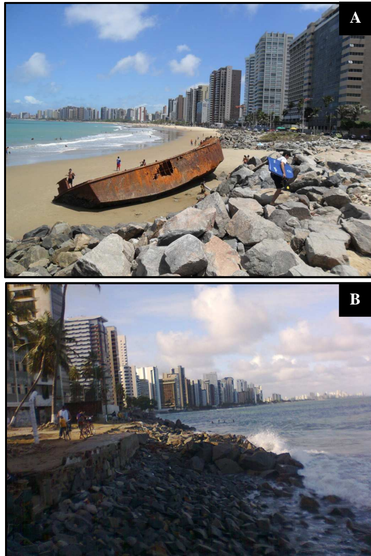
Figura 6.11 – Nas fotos é possível observar que a linha de costa é definida pelas estruturas de defesa costeira, que servem de proteção aos prédios da frente urbana. Nas cidades de Fortaleza (A) e Jaboatão dos Guararapes, Recife-PE (B), a linha de costa é materializada pela sucessão de espigões e enrocamentos que protegem os calçadões e os prédios.
