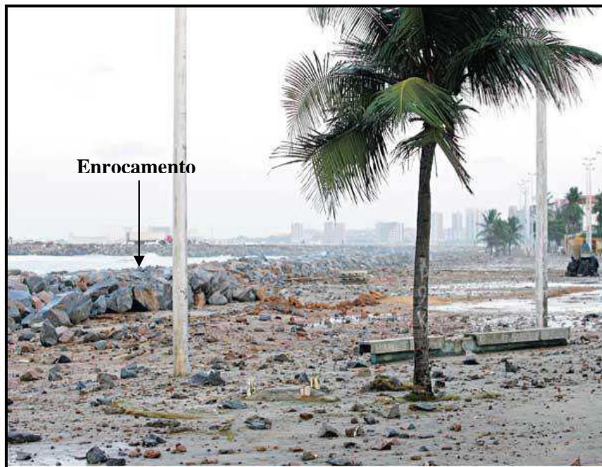
Figura 3.19 – Resto de pedras trazido pelas ondas e depositado no calçadão após uma ressaca do mar. Fotos: A) Rapha Bessa e B) Jornal Diário do Nordeste.
