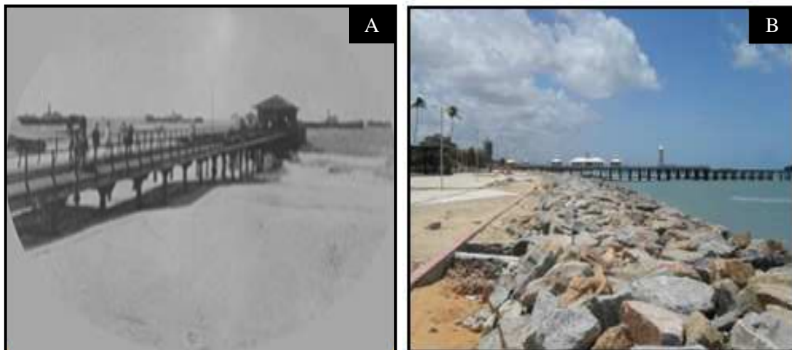
Figura 4.36 - Imagens da Ponte dos Ingleses em diferentes datas. A) Em meados da década de 1920, era visível o assoreamento a que o porto estava sujeito; B) Na década de 2000 a praia já tinha desaparecido dando lugar a um extenso enrocamento paralelo a linha de costa. Fontes: Foto A , arquivo Nirez.
