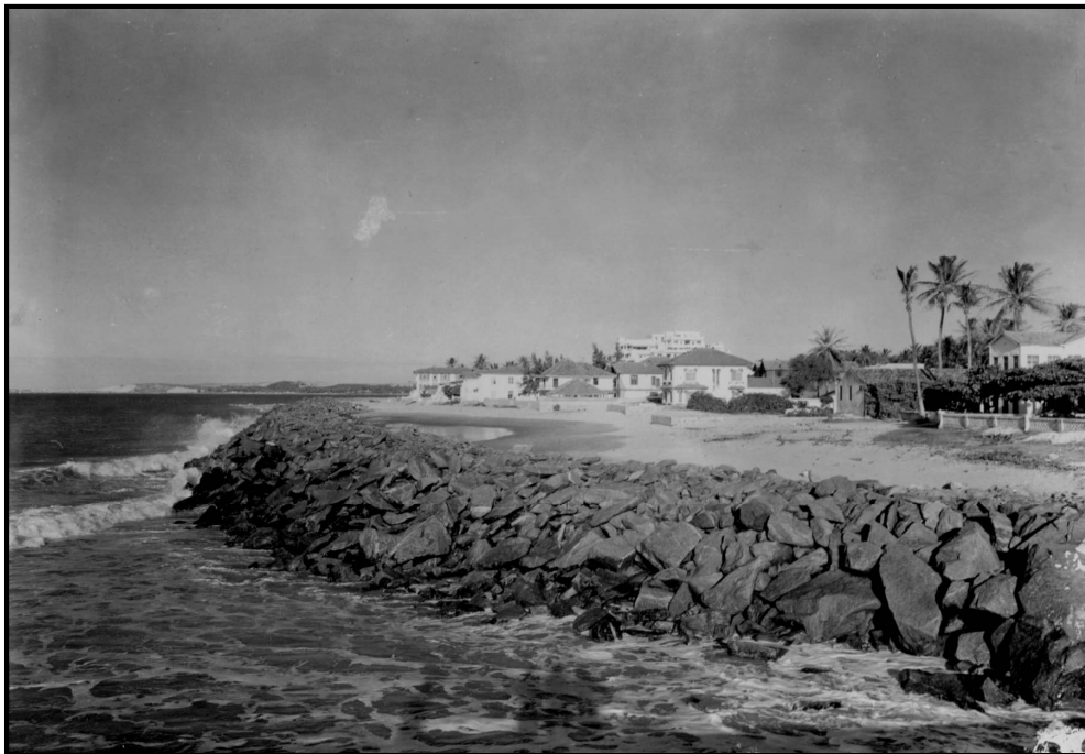
Figura 4.31 - Imagem do enrocamento construído na Praia de Iracema para proteção do conjunto residencial existente nessa praia em 1950. Fonte: Acervo do IBGE – Registro 10304, Foto de Stivan Faludi, negativo 299.
