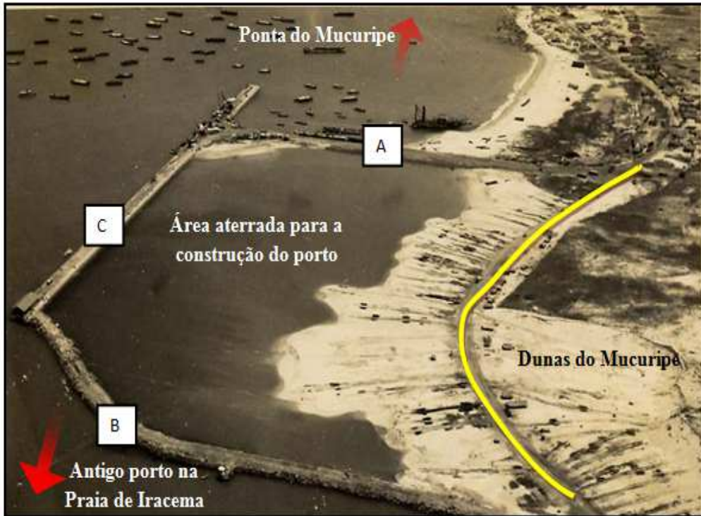
Figura 4.22 - Imagem da construção do aterro hidráulico do Porto do Mucuripe em 1938. Na imagem é perceptível o desmonte das dunas localizadas a retaguarda da obra para a construção do aterro. Fonte: Acervo da Companhia Docas do Ceará.
