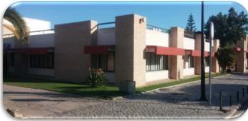
Figura 15 – Vista nordeste/noroeste da ESGHT
