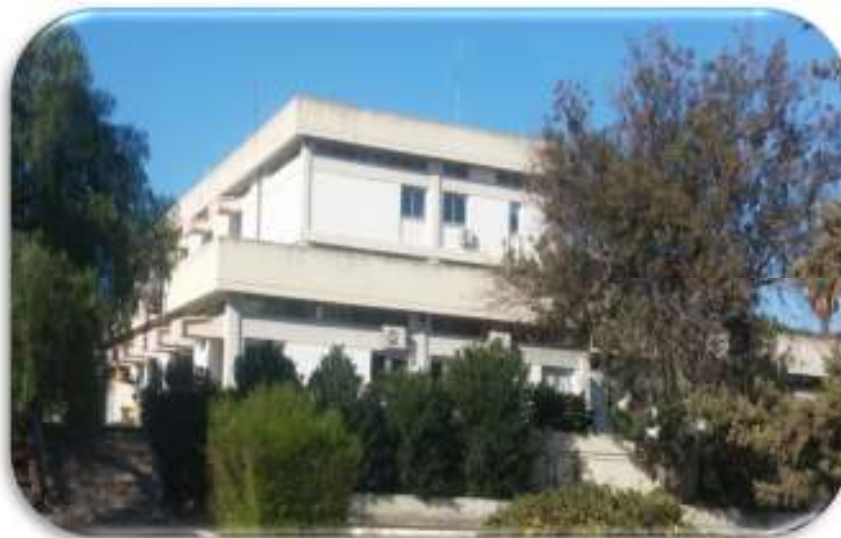
Figura 17 – Vista sudoeste do ISE 1
