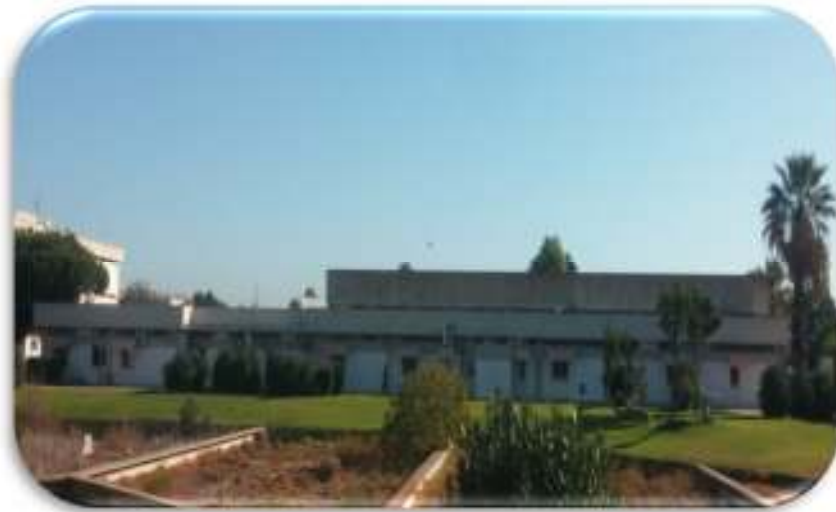
Figura 20 – Vista nordeste do ISE 2
