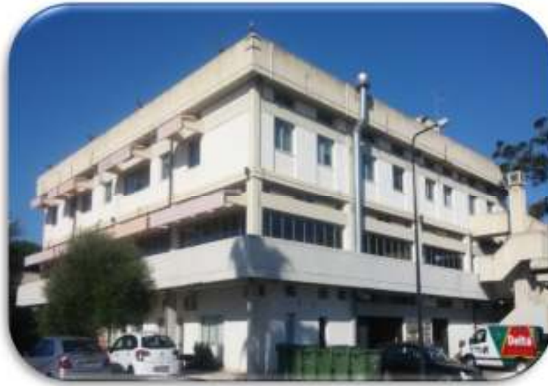
Figura 24 – Vista noroeste/sudoeste da Reitoria
