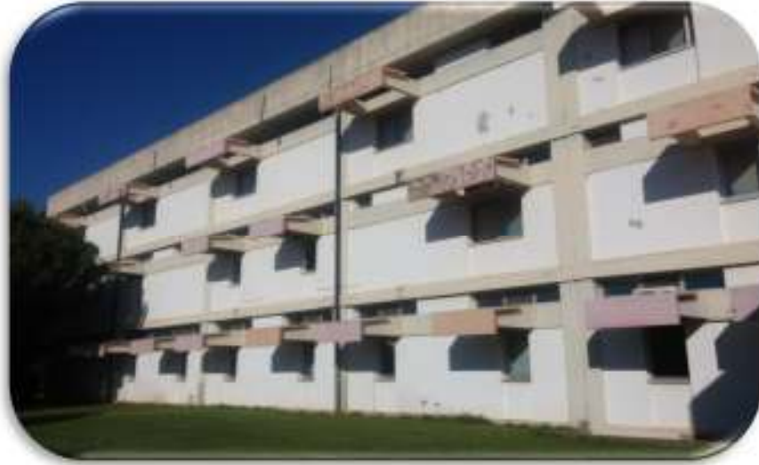
Figura 18 – Vista noroeste do ISE 1
