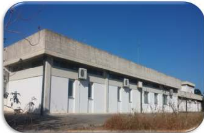
Figura 19 – Vista sudoeste do ISE 2
