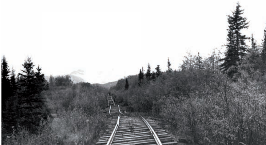
Figura 3 - Efeitos do thermokarst numa linha ferroviária. Fonte: Romanovsky, 2008.
